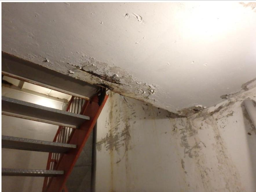
Photographie 7 : Délamination et trace de corrosion dans la cage d'escalier sud
