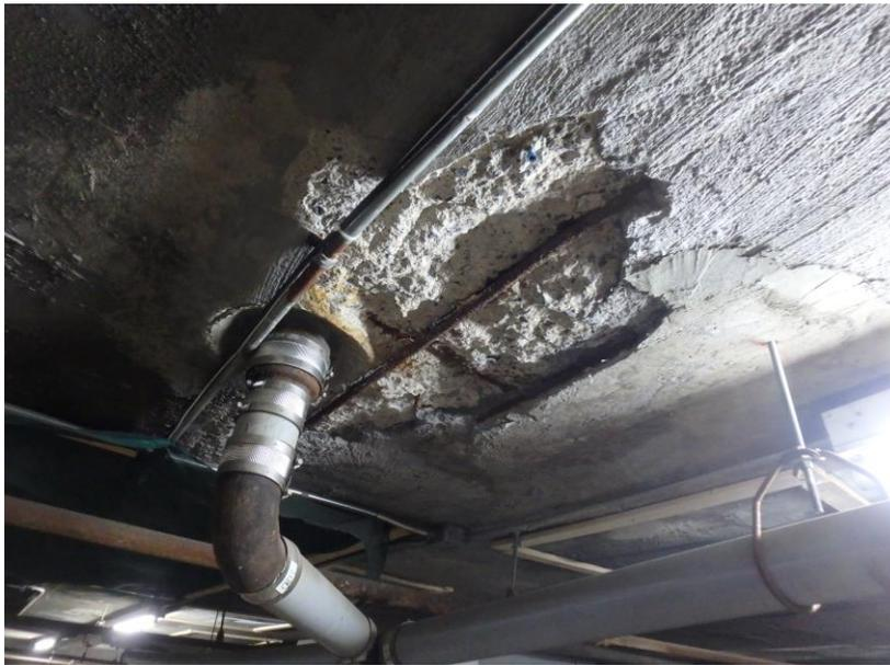
Photographie 1 : Délamination du béton et corrosion de l'acier d'armature
