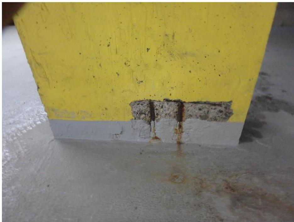
Photographie 4 : délamination du béton et corrosion des barres d'armatures visibles
