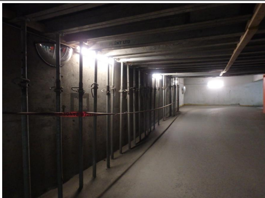
Photographie 2 : Étalement de la section à proximité de la rampe d'accès
