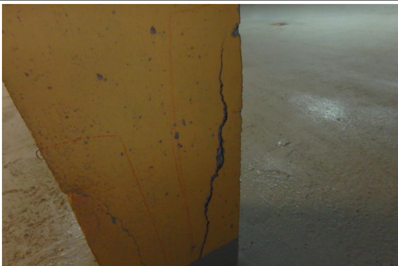
Photographie 3 : délamination de la base d'une colonne
