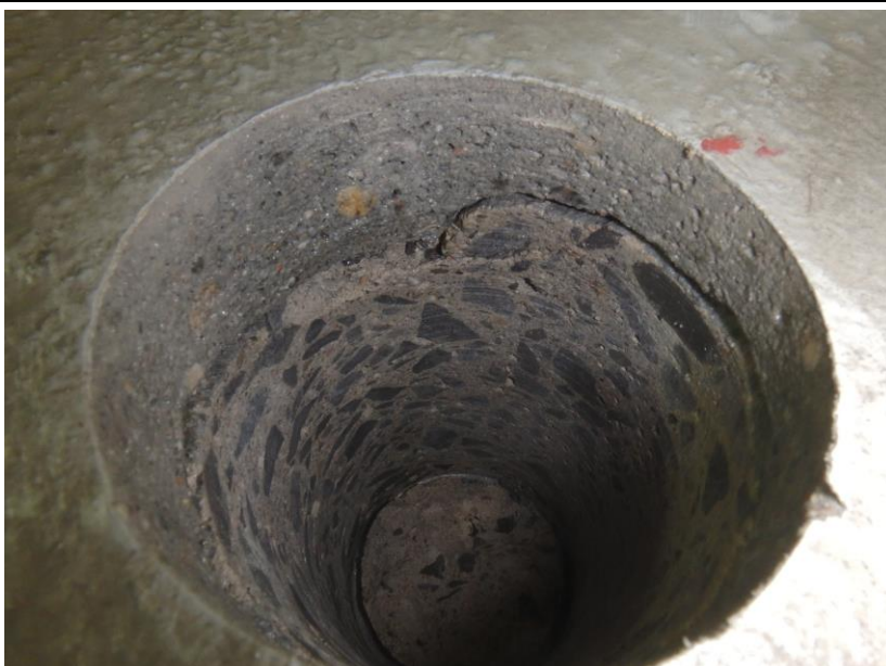
Photographie 6 : Localisation de l'échantillon C-14 présentant de la délamination
