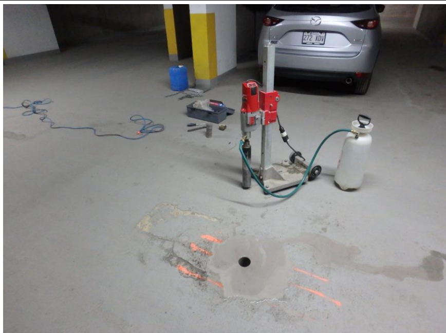
Photographie 5 : Échantillonnage de la dalle 2 à l'aide d'une carotteuse
