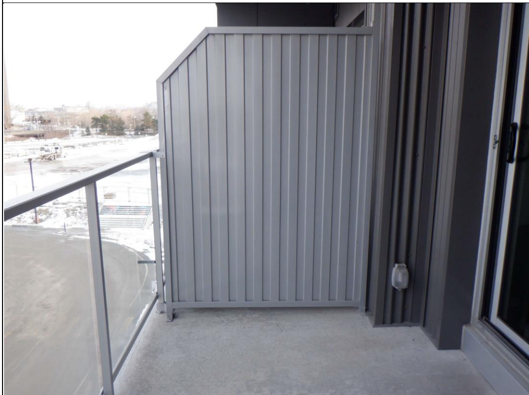
Panneau séparateur au balcon.
