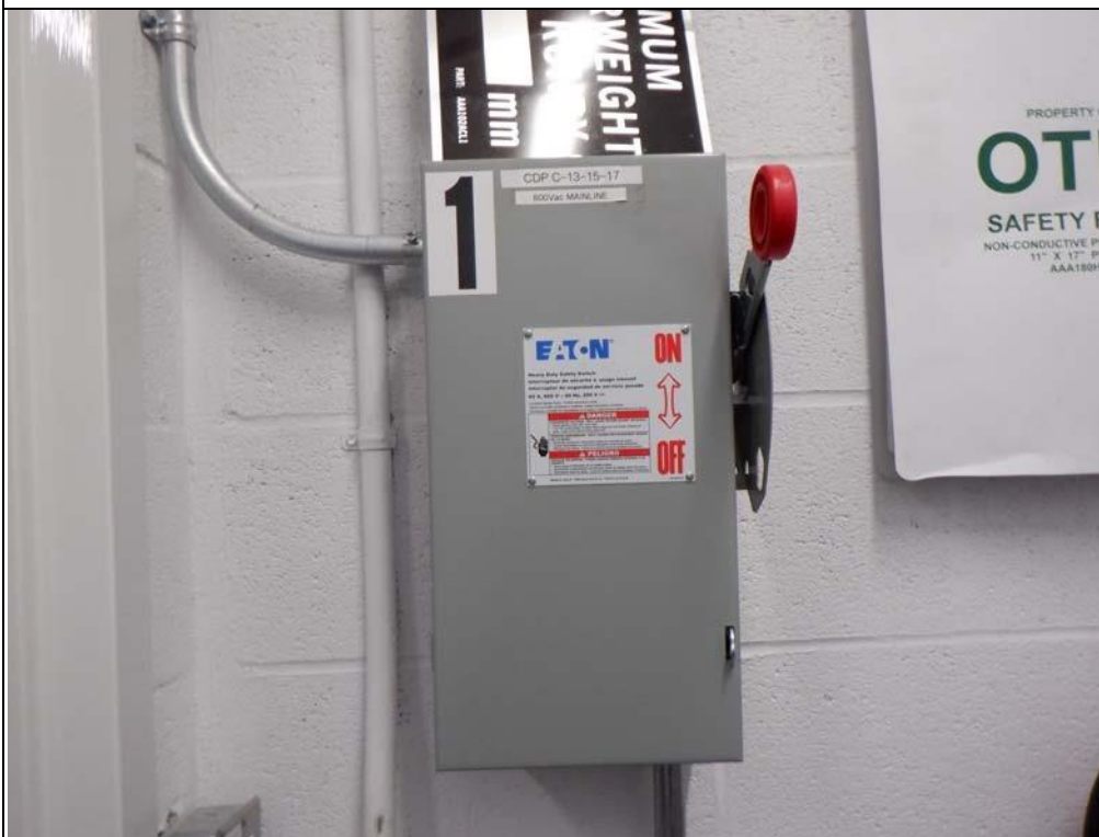
Interrupteur de commande pour ascenseur 60A 600V 60hz 250V.
