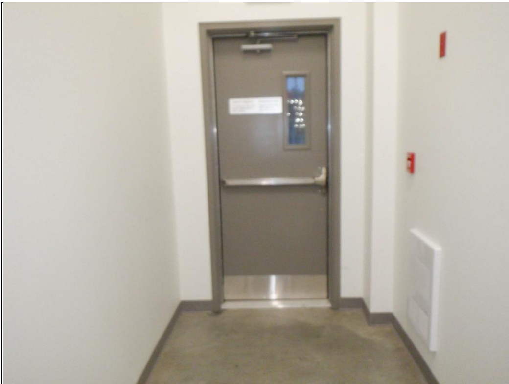
Porte sortie de secours arrière.
