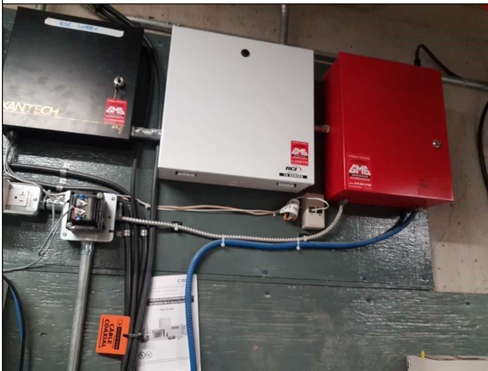
Boîtes de jonction pour les contrôleurs de portes.
