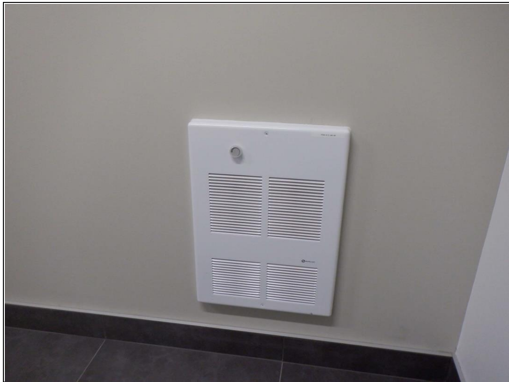
Appareil de chauffage électrique 4KW aéroconvecteur commercial Ouellet
