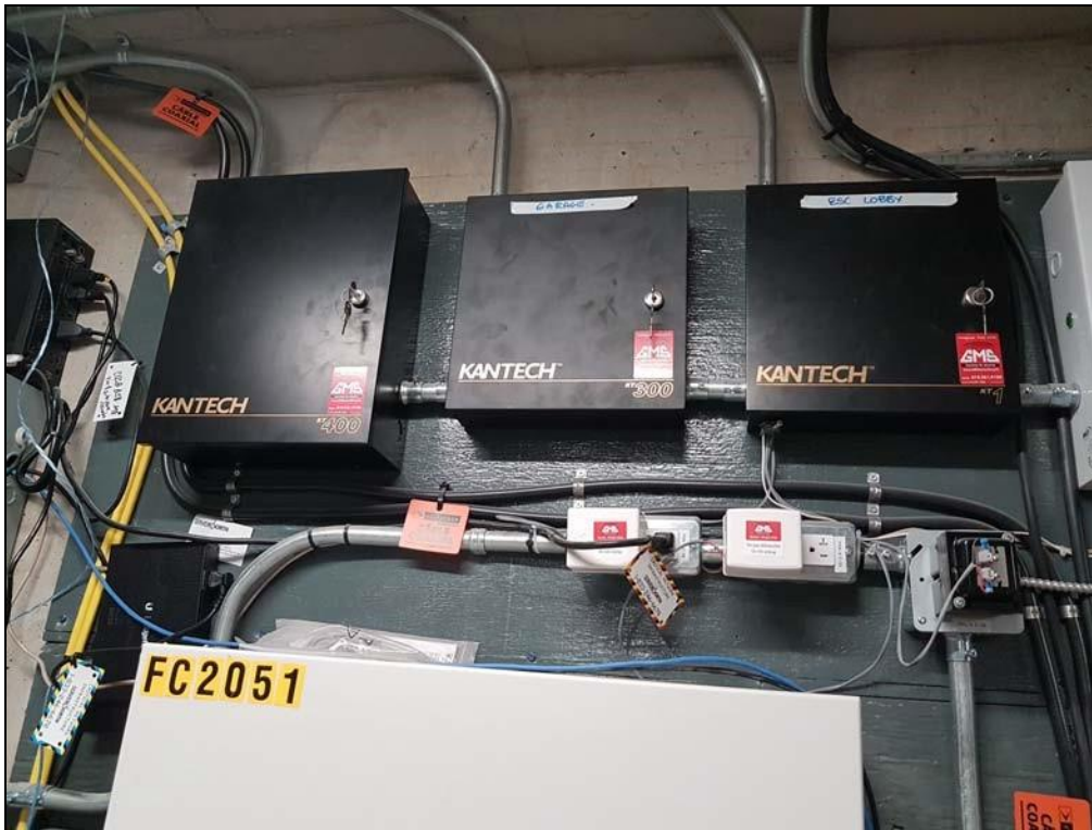
Contrôleur quatre portes Kantech KT-400 compatible Ethernet; Contrôleur quatre portes Kantech KT-1.
