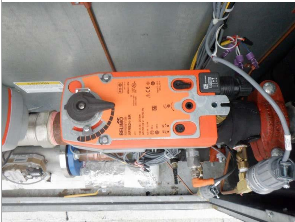
Vanne de régulation à boisseau sphérique (CCV), 1 1/4", 2 voies, Cv 25 Servomoteur de vanne, Ressort de rappel, AC/DC 24 V, 2...10 V, BELIMO AFRB24-SR.
