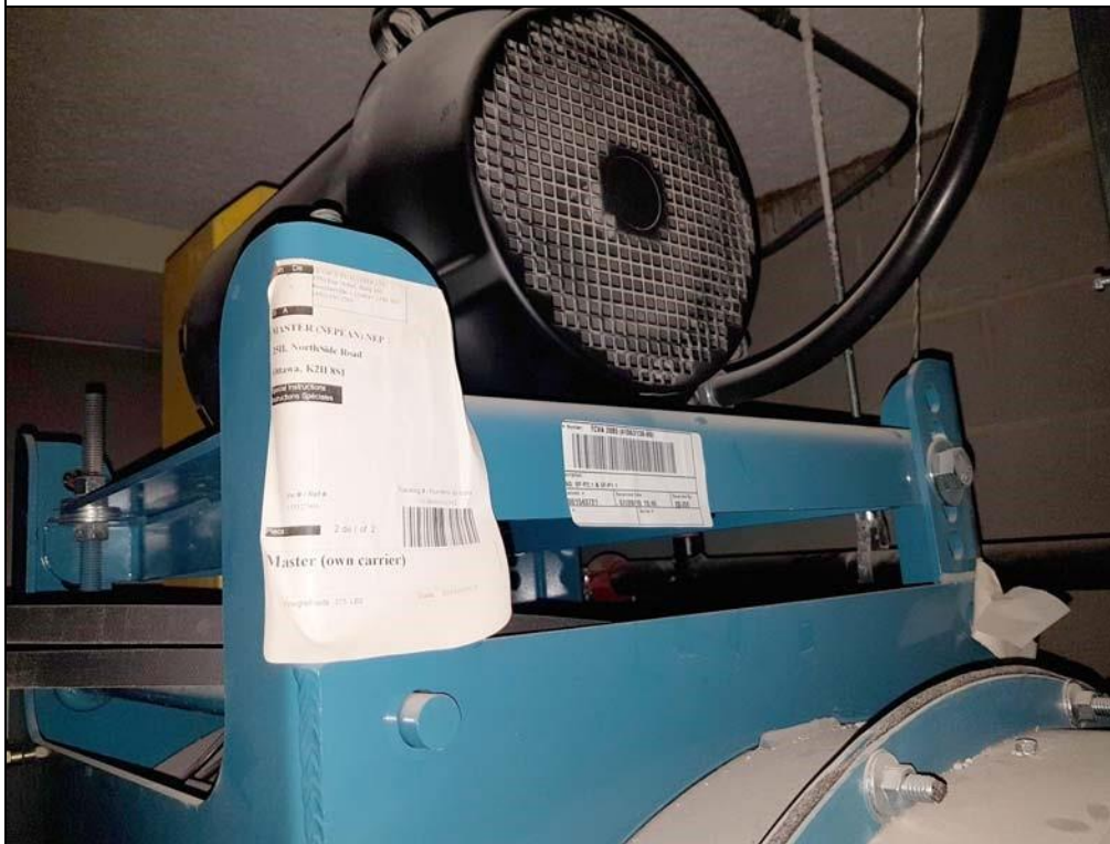
Ventilateur du garage (sortie) à entrainement par courroie TCVA AXIFAN, TWIN CITY FAN TCVA 28B5.
