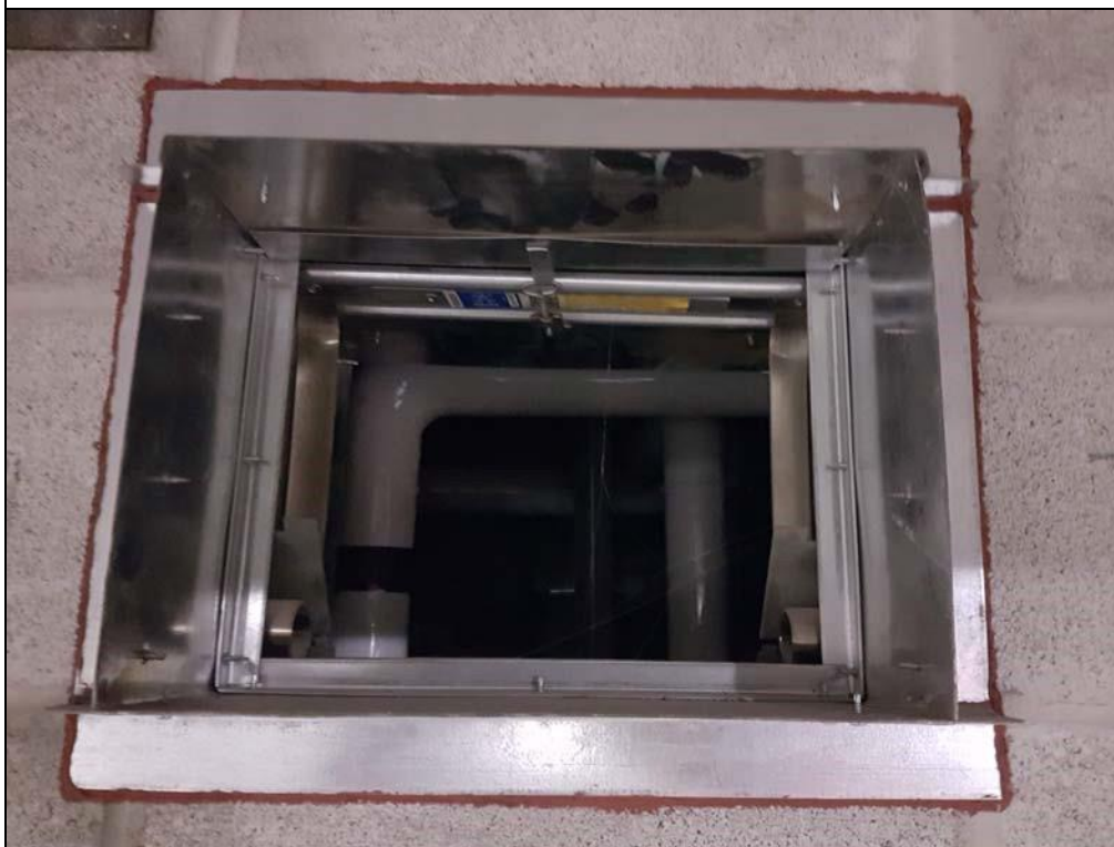
Clapet coupe-feu type rideau 18x12 51AHS-SS Acier inoxydable 1-1 / 2 heures type A VENTEX Inc. (Alumavent Inc.).
