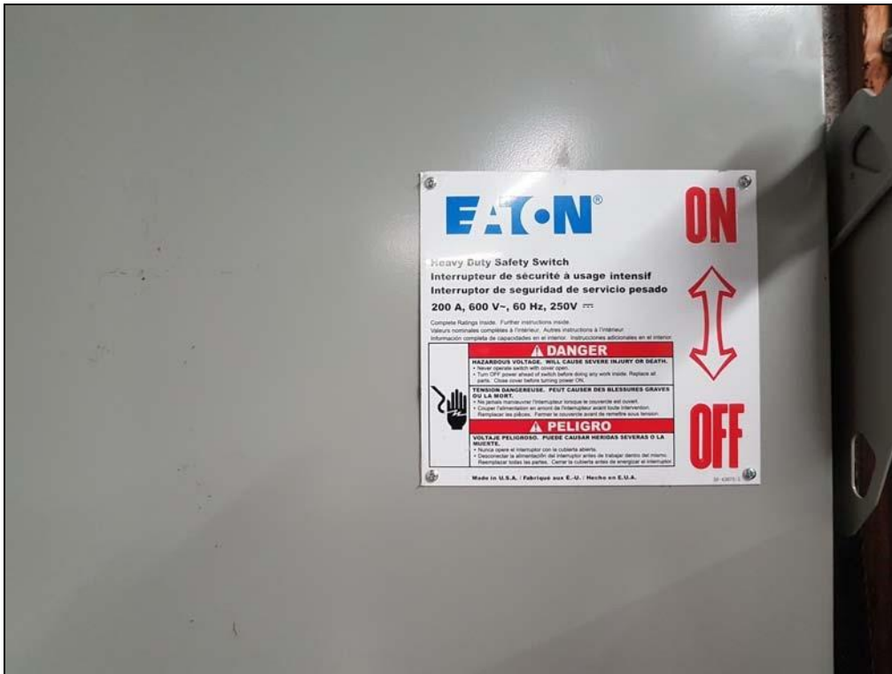
Interrupteur-sectionneur de sécurité à usage intensif, 3 pôles, 600 V, 200 A, Eaton DH364FRK.
