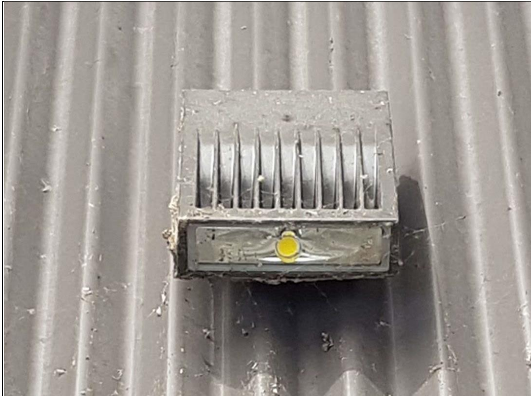
Lumière extérieure Sortie de secours arrière.
