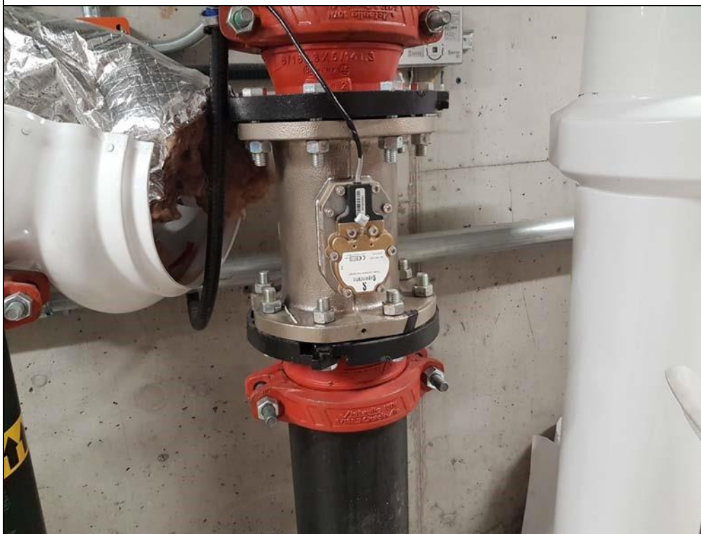
Capteur hydraulique à oscillation fluïdique Superstatic 100 m 3 /h 0.317 p/l de-07-m004-ptb012 Sontex Superstatic 835.
