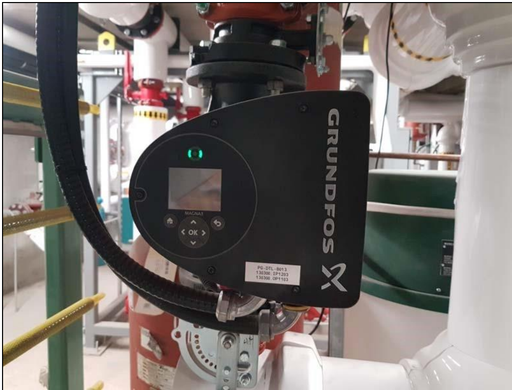
La pompe de circulation Grundfos MAGNA3 80-100 F-360.
