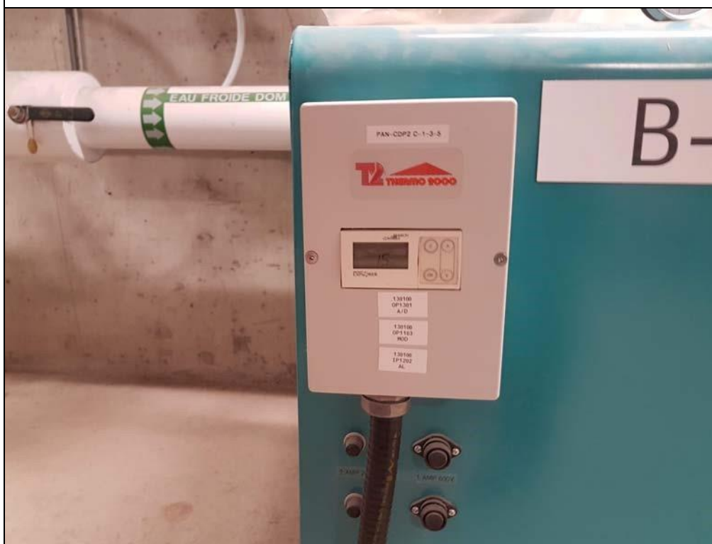
B1 Panneau de contrôle de la bouilloire électrique DTH ULTRA de 42 à 144KW Thermo2000.
