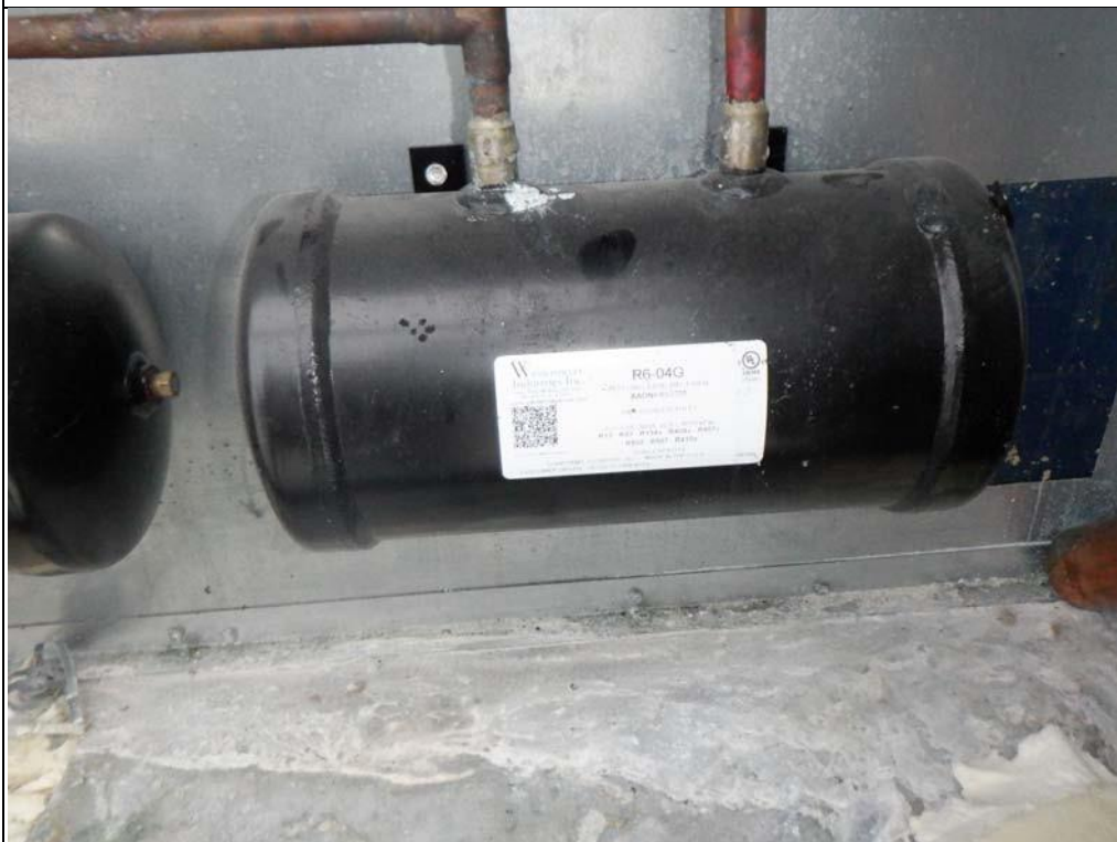
Récepteurs de liquide UL haute pression pour appareil au toit Westermeyer Industries, IncR6-04G.
