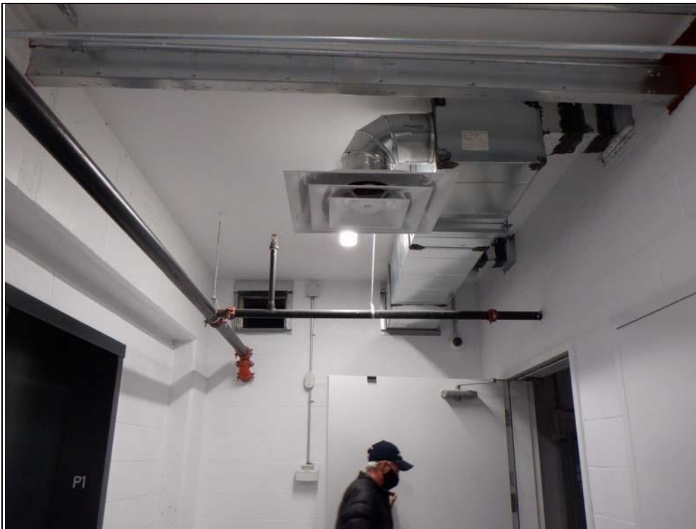
Plafond vestibule ascenseur P-1.
