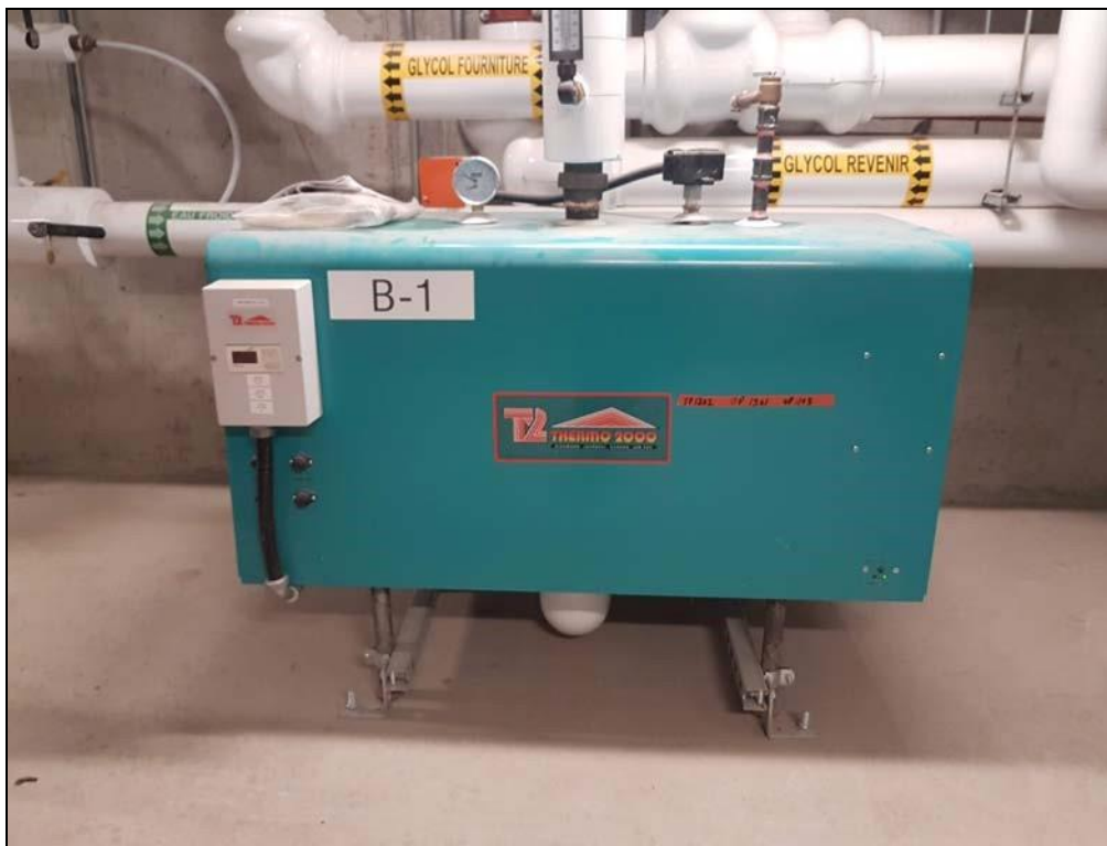
B1 Bouilloire électrique DTH ULTRA de 42 à 144KW Thermo2000.
