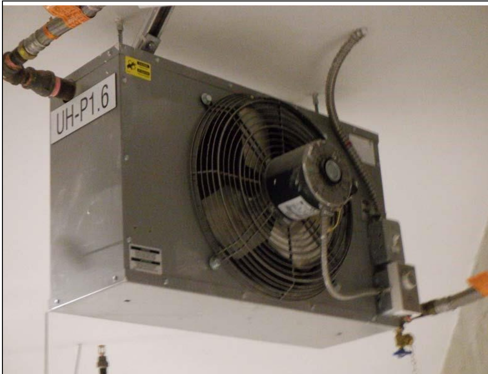
Appareil de chauffage hydronique et Moteur 1/6 Hp, 115, 48Y FR., 3 PH, 1075 Rpm, TEAO Marathon-Motors.com X306.
