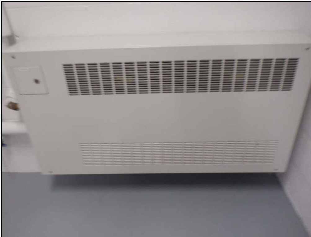
Chaufferette à air propulsée (convecteur) SIGMA CORPORATION CWF 48x26x6.5.
