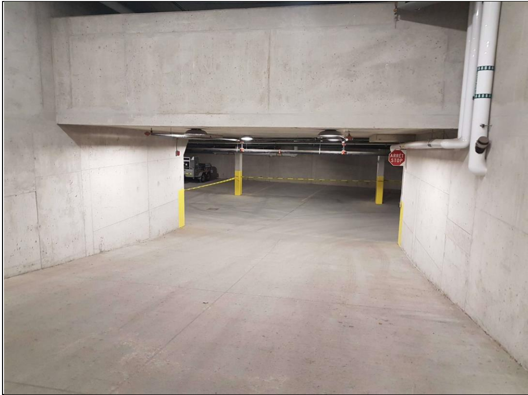
Entrée du garage P-2.
