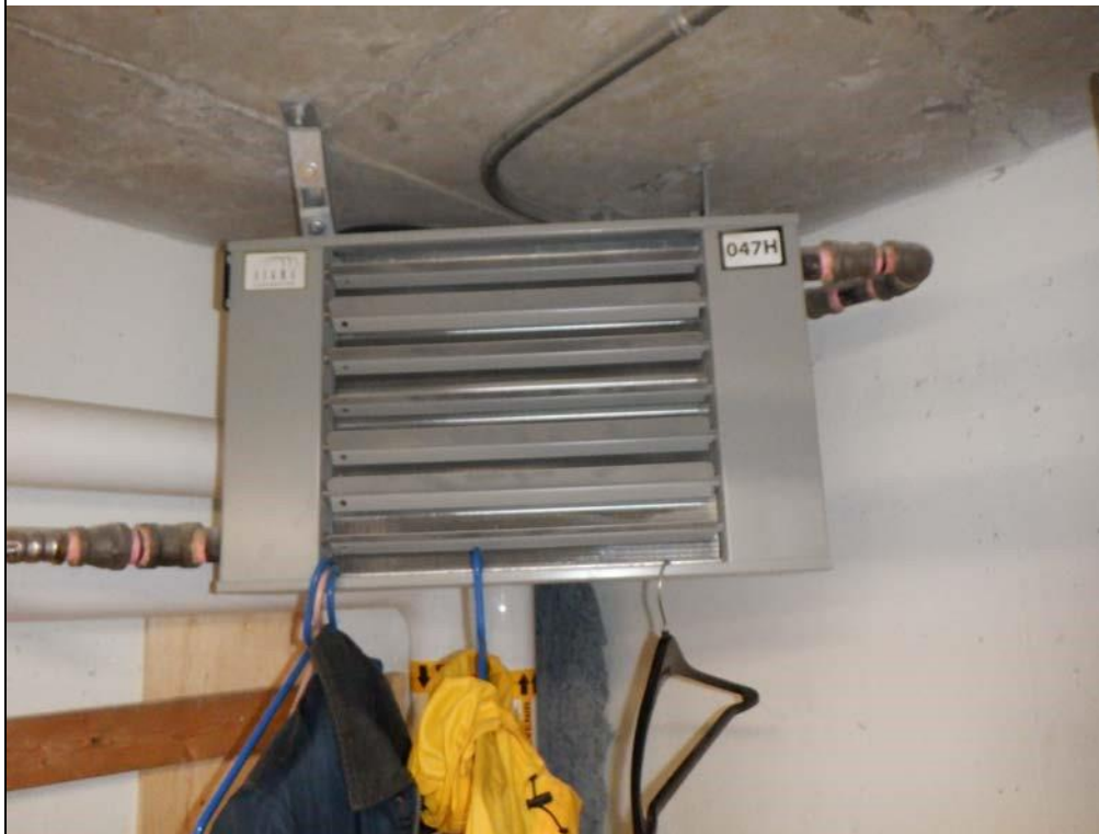
UH-P1.3 Aérothermes hydroniques SIGMA CORPORATION SUH-C 0-047H.
