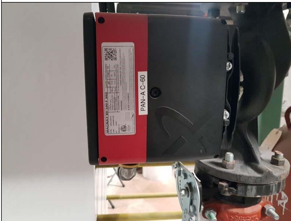
La pompe de circulation Grundfos MAGNA3 80-100 F-360.
