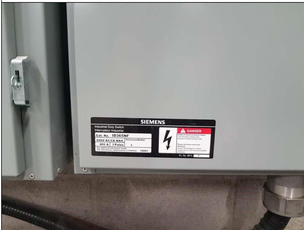
SIEMENS CANADA ID365NF 400Amp 600VAC 250VDC 3 pôles interrupteur industriel sans fusible Siemens EEMAC 1 boîtier.
