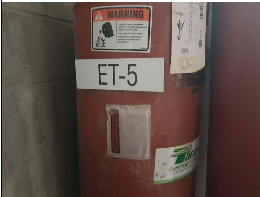
Réservoir à vessie d'expansion d'eau potable de 22 gal TACO PAX84-150.
