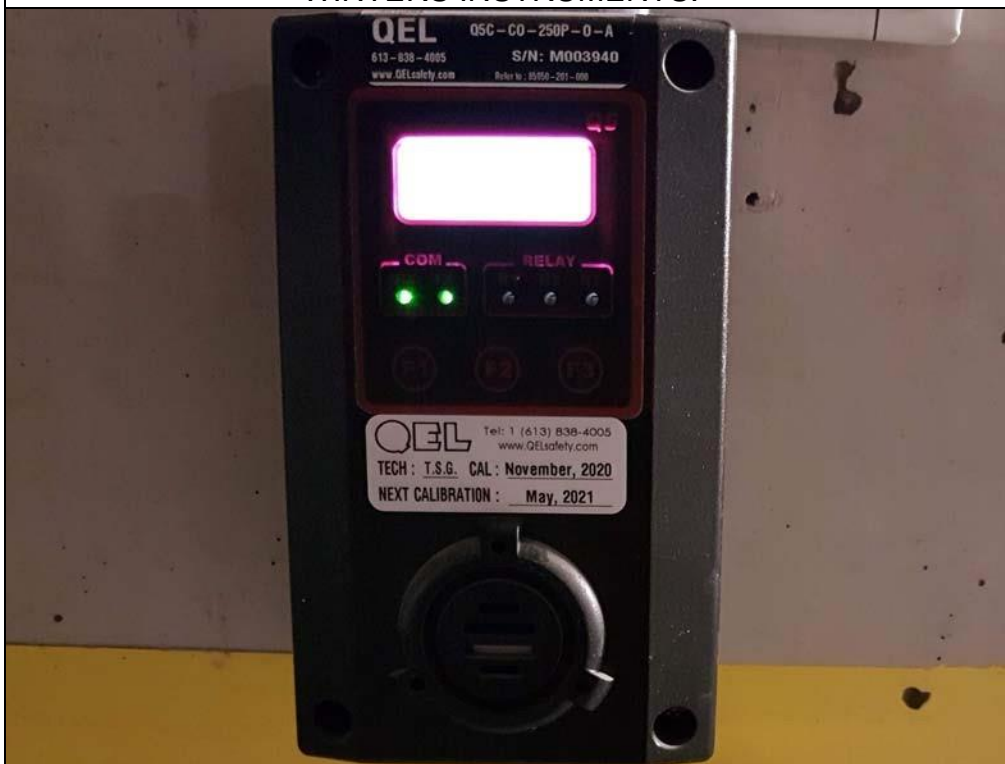
Détecteur de monoxyde de carbone QEL Q5-CO-250P-0-X.
