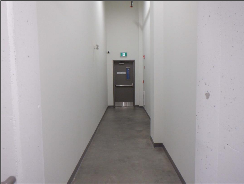
Corridor de la sortie arrière, niveau R-de-C.
