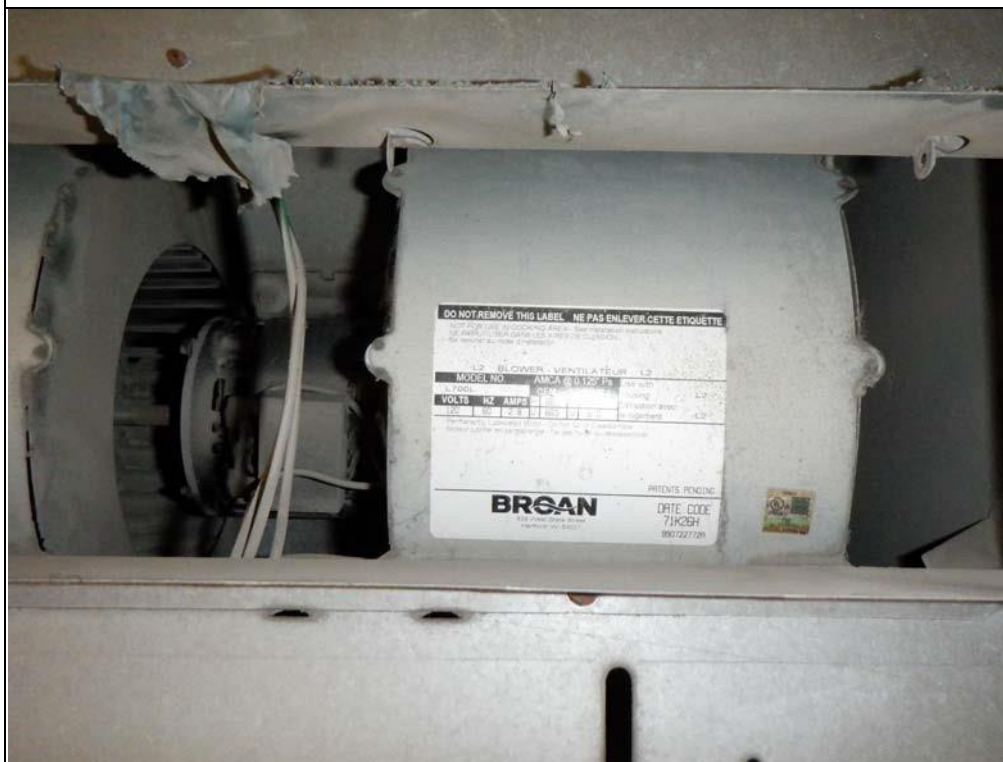
Ventilateur haute capacité Broan-Nutone L700L, ventilateur d'extraction commercial, 3,7 sons, 681 CFM.
