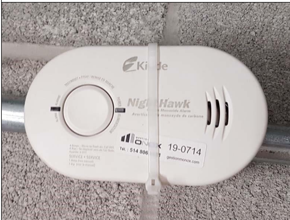
Alarme de monoxyde de carbone à piles KIDDE KN-COB-B-LS-CA.
