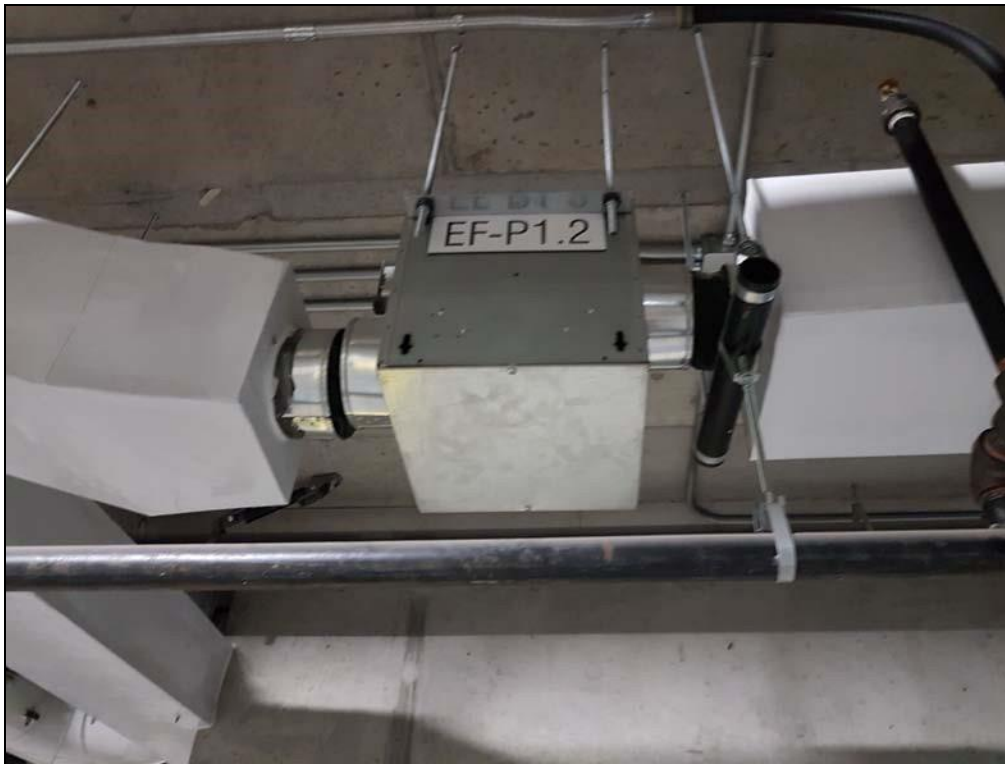
TF-P1.2Serpentin électrique sur mesure dans un boîtier SDHF200x150-3K600V3P-CIR047-N STELPRO.
