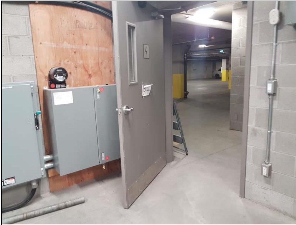
L'alarme de monoxyde de carbone à piles KIDDE KN-COB-B-LS-CA est situé à l'entrée sur la conduite électrique de la lumière.
