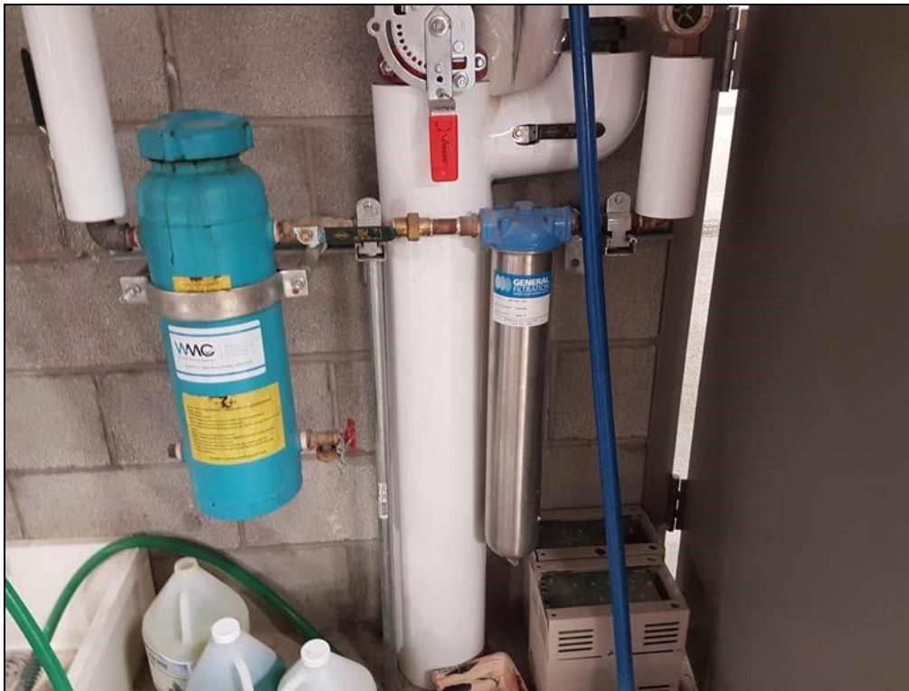
WMC by-pass feeder avec Cartouche pour filtre GENERAL FILTRATION GFO 20-3/4.
