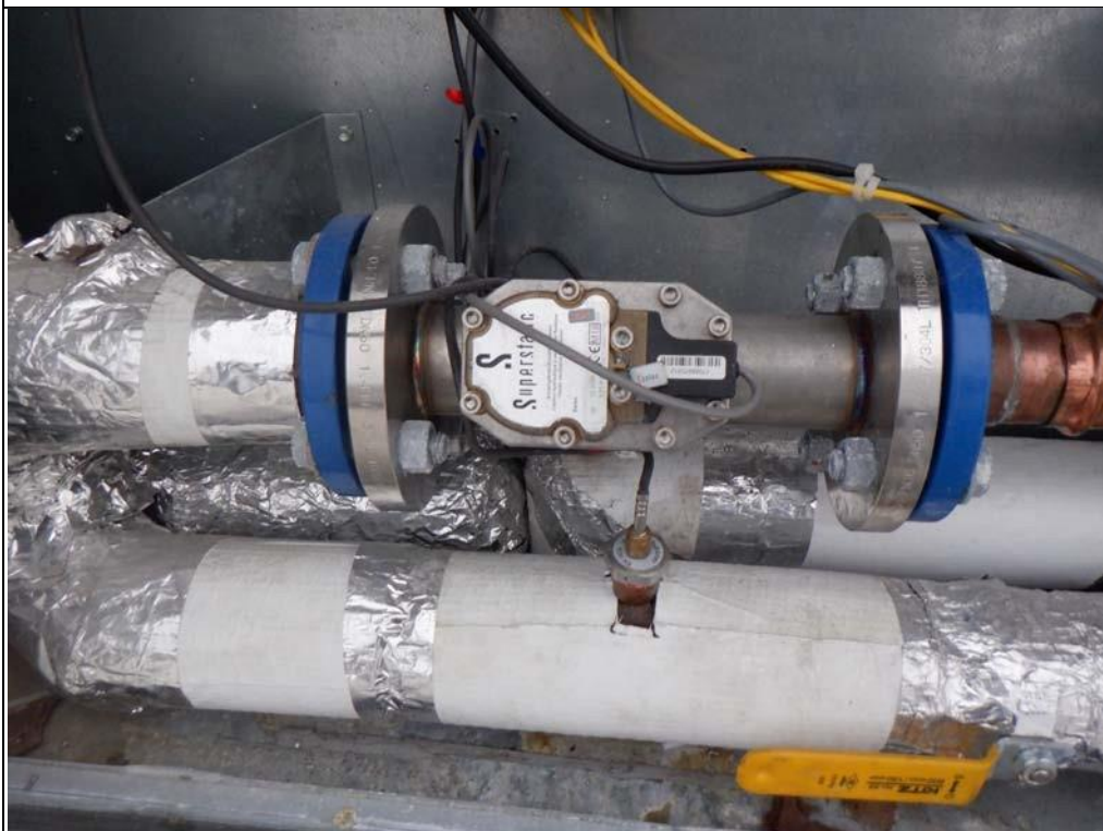
Capteur hydraulique à oscillation fluïdique Superstatic 1.5 m 3 /h 3.77 P/L De-07-M004-PTB012SONTEX440.
