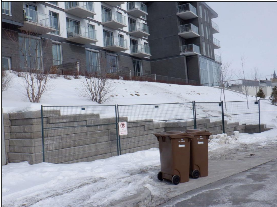
Mur de soutient arrière.
