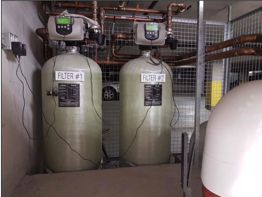
Réservoirs et valves de contrôle électronique Clack-WS2H-and-WS3.
