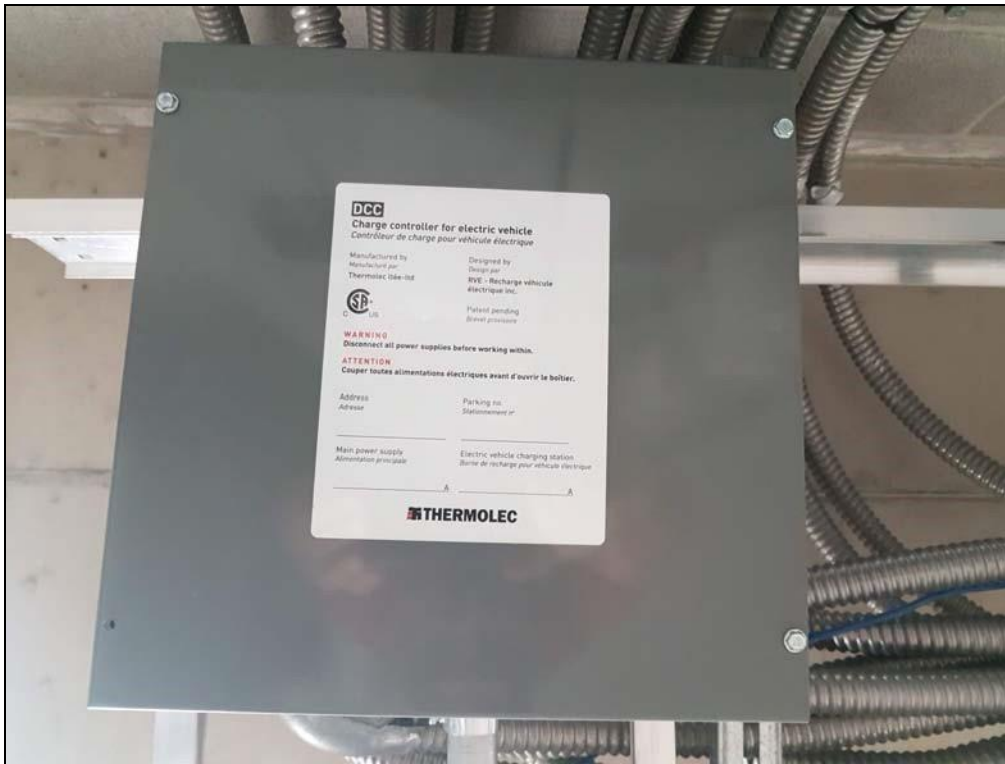
Contrôleur de charge pour véhicule électrique DCC-9 40A Thermolec.
