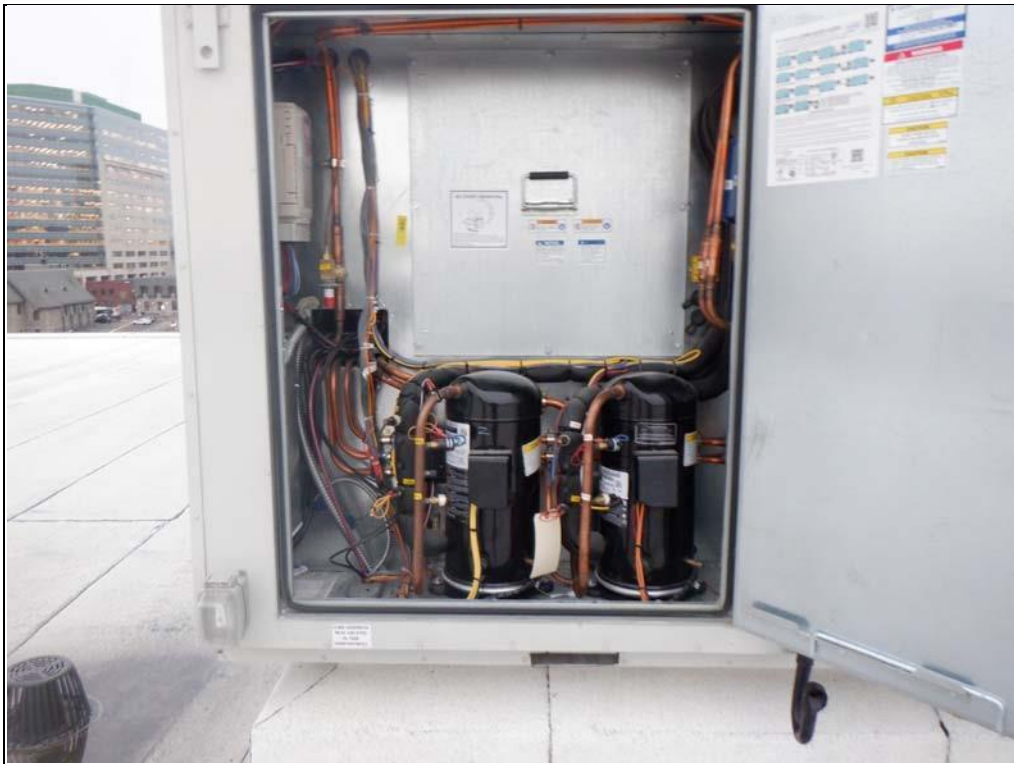
Vue générale de la porte en façade avant à gauche.
