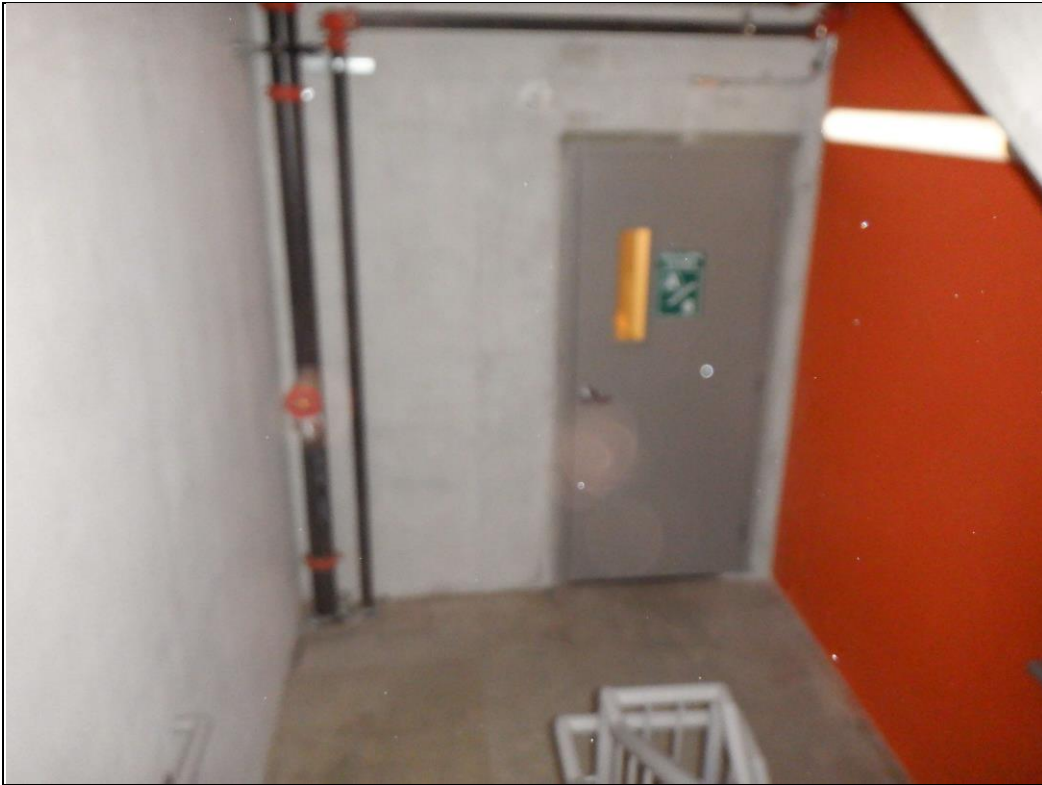
Porte donnant accès à l'escalier niveau 6.
