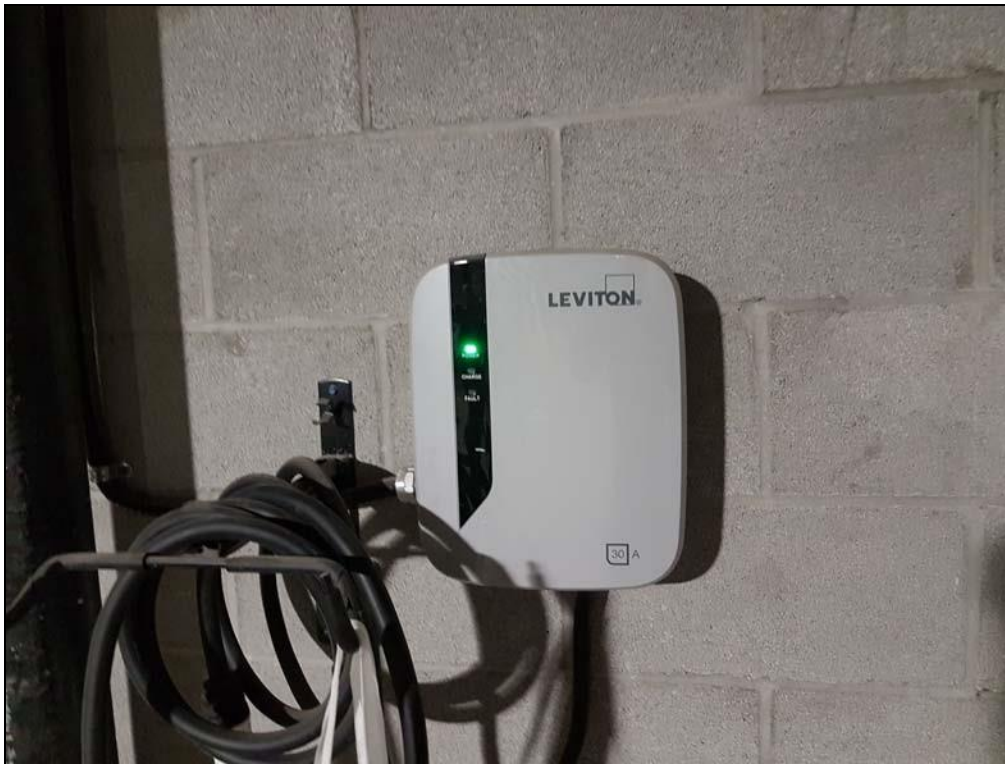
Leviton Chargeur 30 Amp pour auto électrique, borne de recharge Evr-Green avec câble de 18 pieds.
