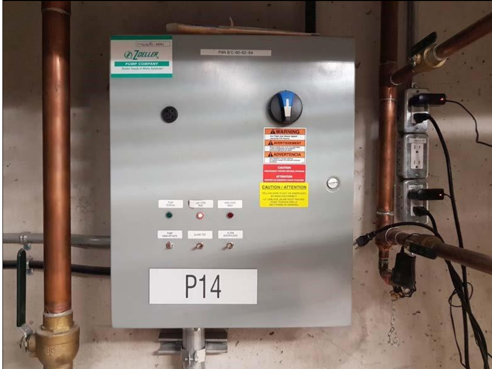
Panneau de contrôle pour la pompe submersible de broyage 7.5 hp 25.3 fla 200V phases Zoeller Série 71 et X71.
