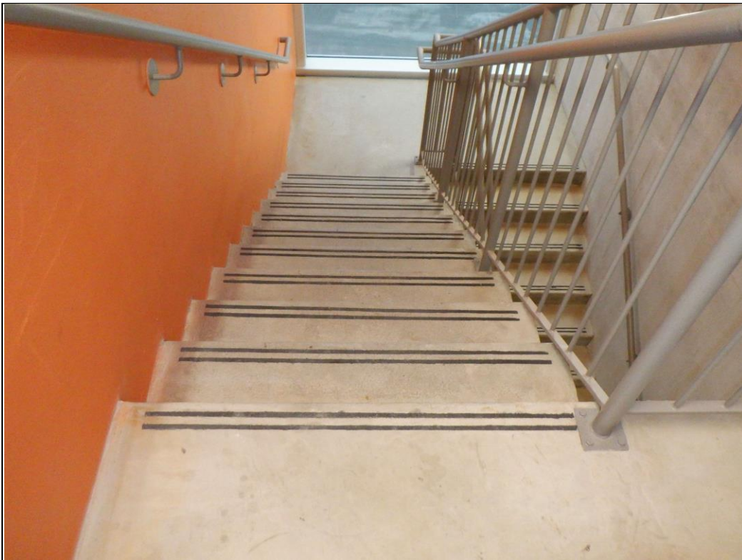
Escalier de secours type en façade
