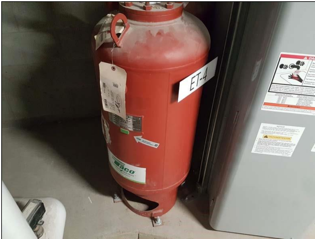
Réservoir à vessie d'expansion d'eau potable de 22 gal TACO PAX84-150.
