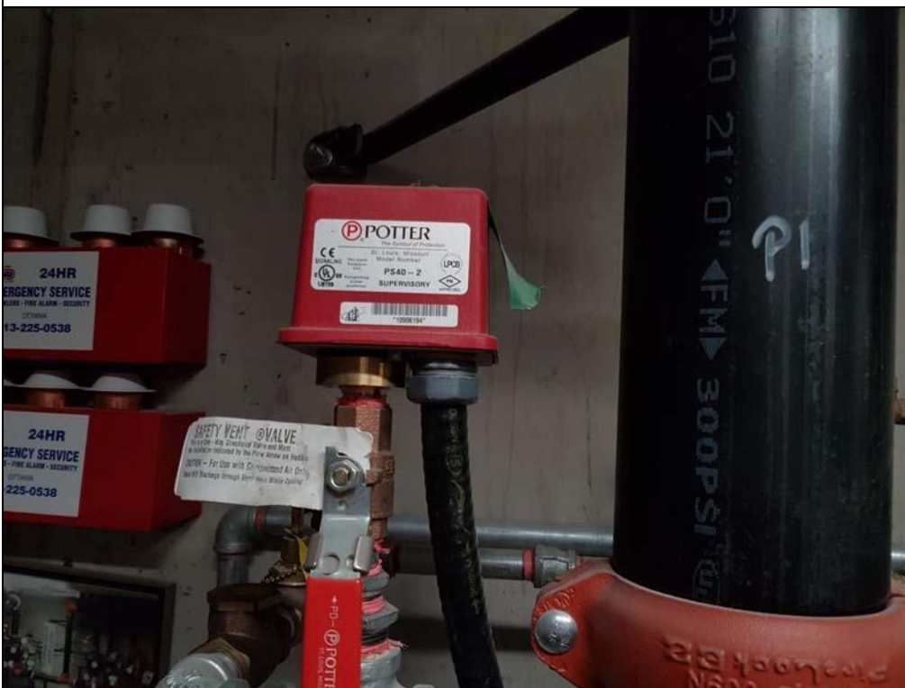
Pressostat de surveillance basse / haute pour vannes sèches - Pression nominale du système 40 psi Potter Electric Signal Company, LLC PS40-2.
