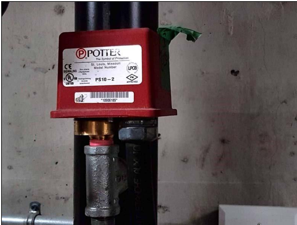
Pressostat de surveillance basse / haute pour vannes humide Potter Electric Signal Company, LLC Série PS10.
