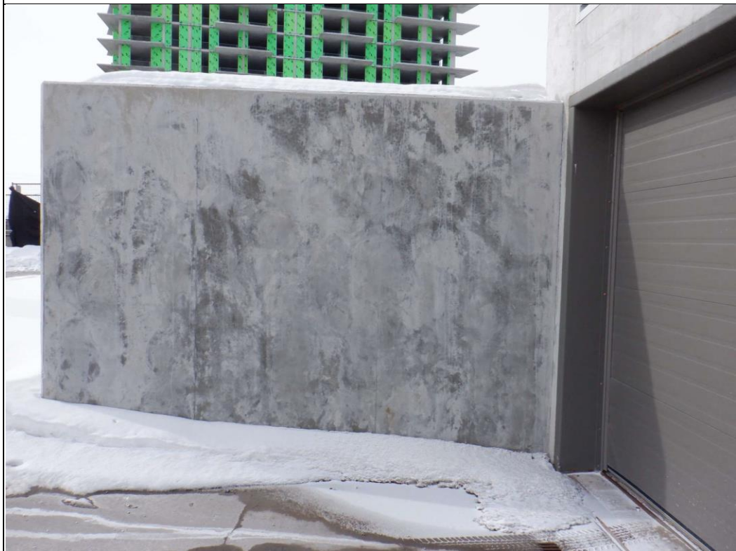
Mur de soutènement de chaque côté des portes de garage.
