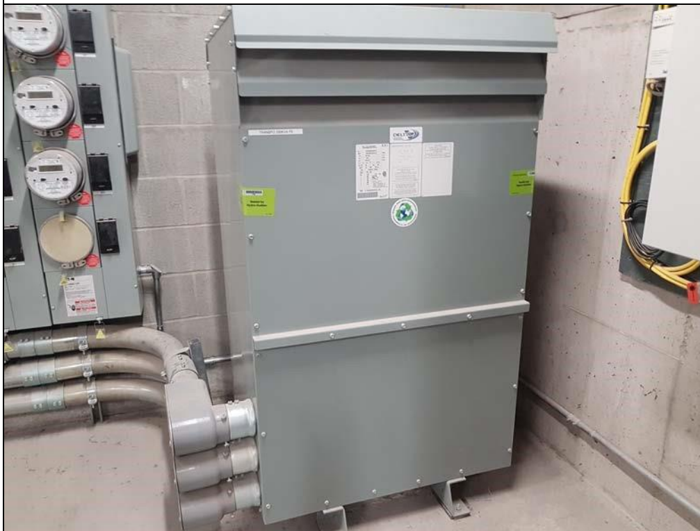
Transformateur Delta 200 kva 600/120/240 CD2A0200VKA6XXLD.
