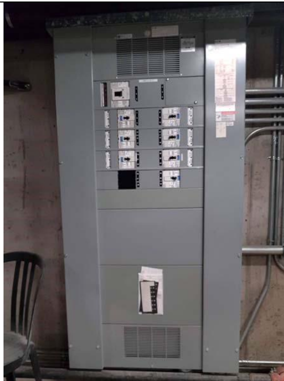
Panneaux de distribution Pow-R-Line 4 à compteur multipoints Power Xpert EATON PRL4.
