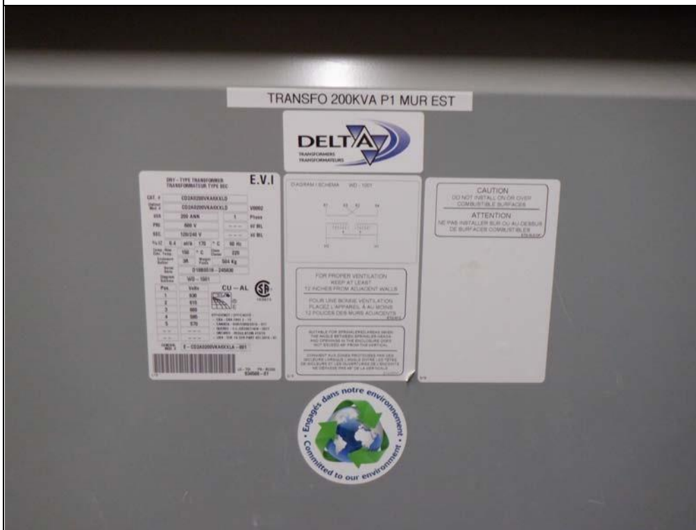
Transformateur Delta 200 kva 600/120/240 CD2A0200VKA6XXLD Delta, CD2A0200VKA6XXLD.
