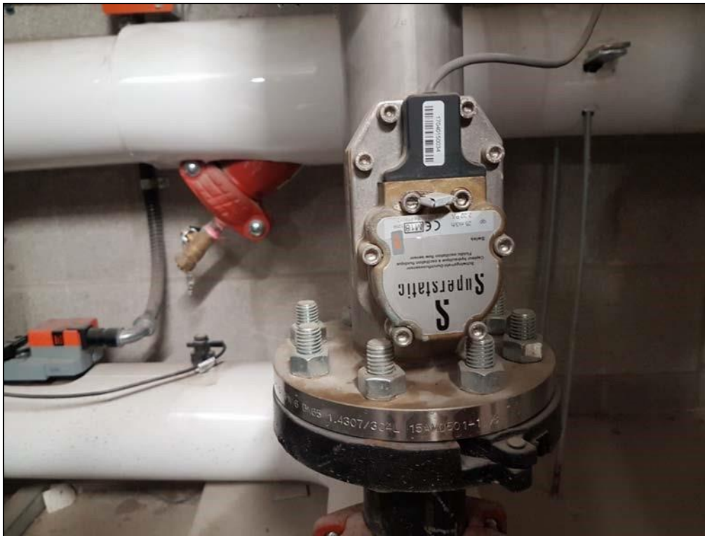
Capteur hydraulique à oscillation fluide Superstatic 100 m 3 /h 0.317 p/l de-07-m004-ptb012 Sontex Superstatic 835.
