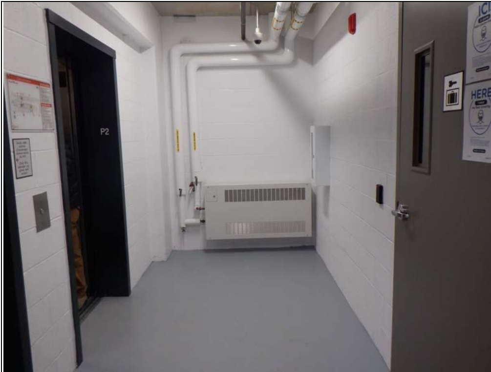
Vestibule des ascenseurs au P2.
