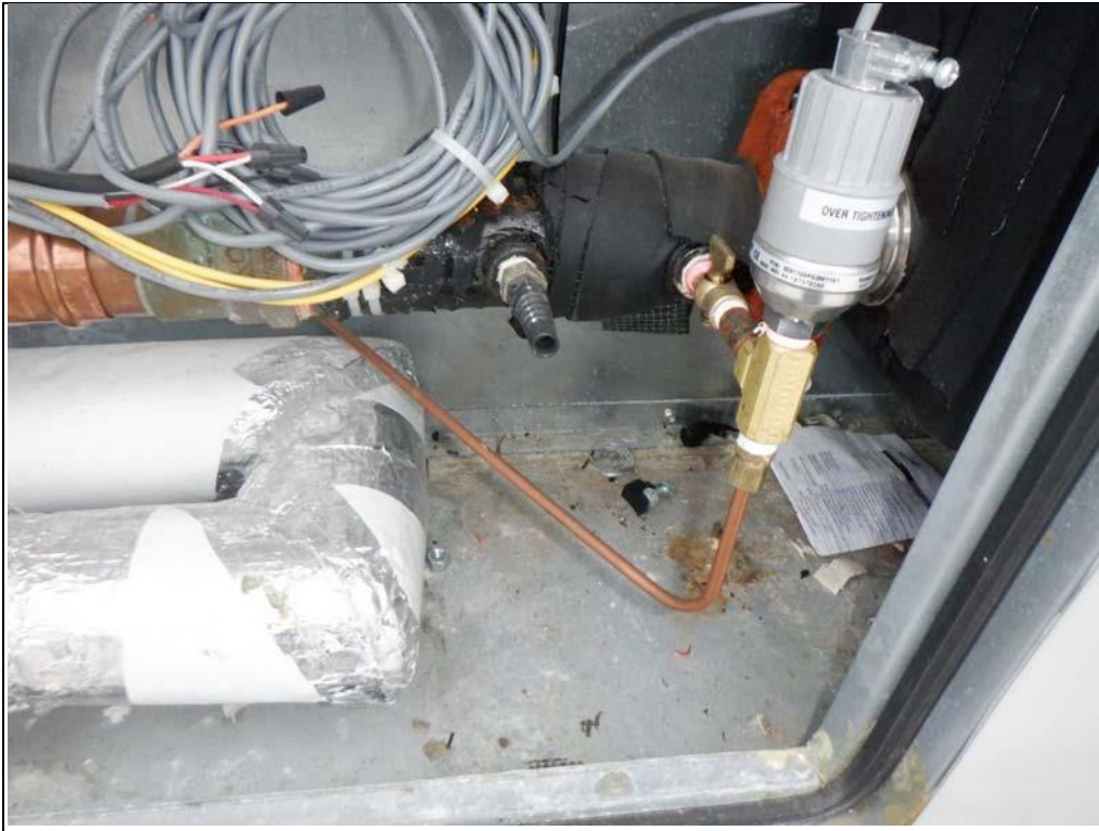
Capteur de pression SETRA série 209 SETRA 2091100PG2M11A1.
