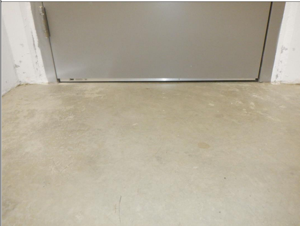
Seuil tombant sur porte d'escalier et sas.
