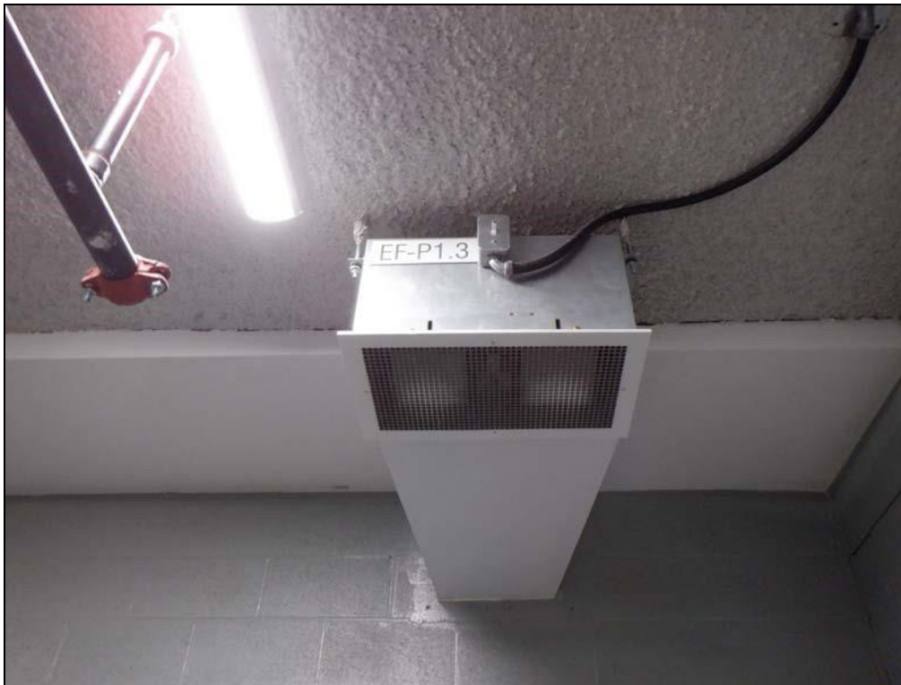
EF-P1.3 Ventilateur haute capacité Broan-Nutone L1500, ventilateur d'extraction commercial, 8,4 sons, 120 V, 1513 CFM BROAN L1500.
