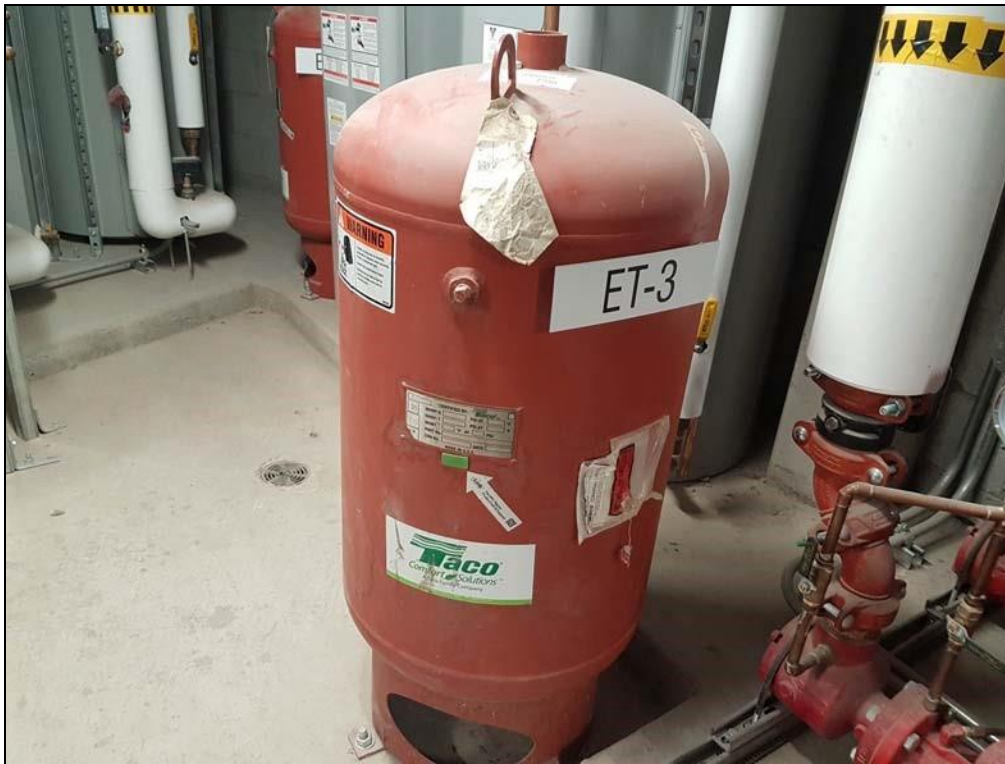
Réservoir à vessie à expansion verticale de 45 gal TACO CBX170-125.
