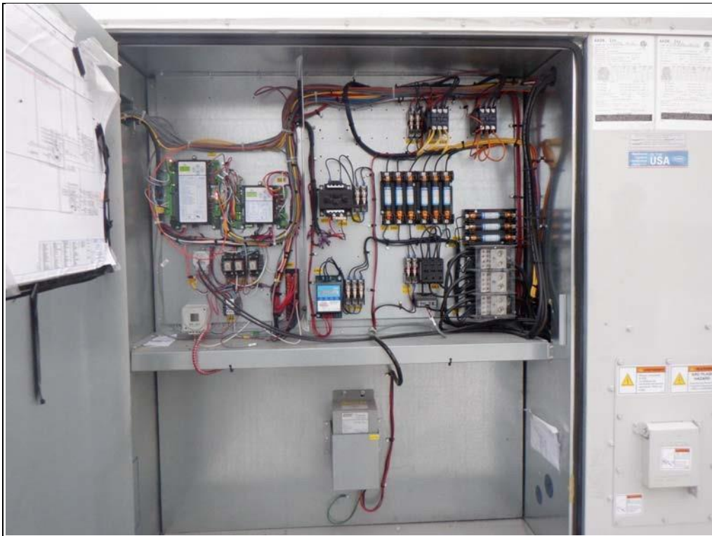
Panneau des cartes électronique et des fusibles.
