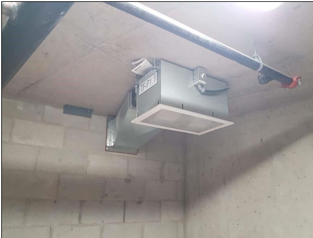
Ventilateur haute capacité Broan-Nutone L1500, ventilateur d'extraction commercial, 8,4 sons, 120 V, 1513 CFM.
