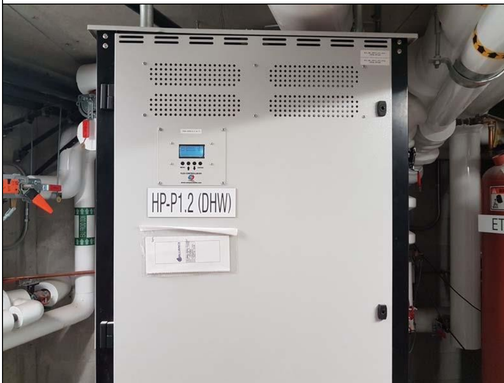
HP-P1.2 Unités à double compresseur Compax 4 Tailles 600 1-888-220-5551 Group CGC CMS600f4-110x.
