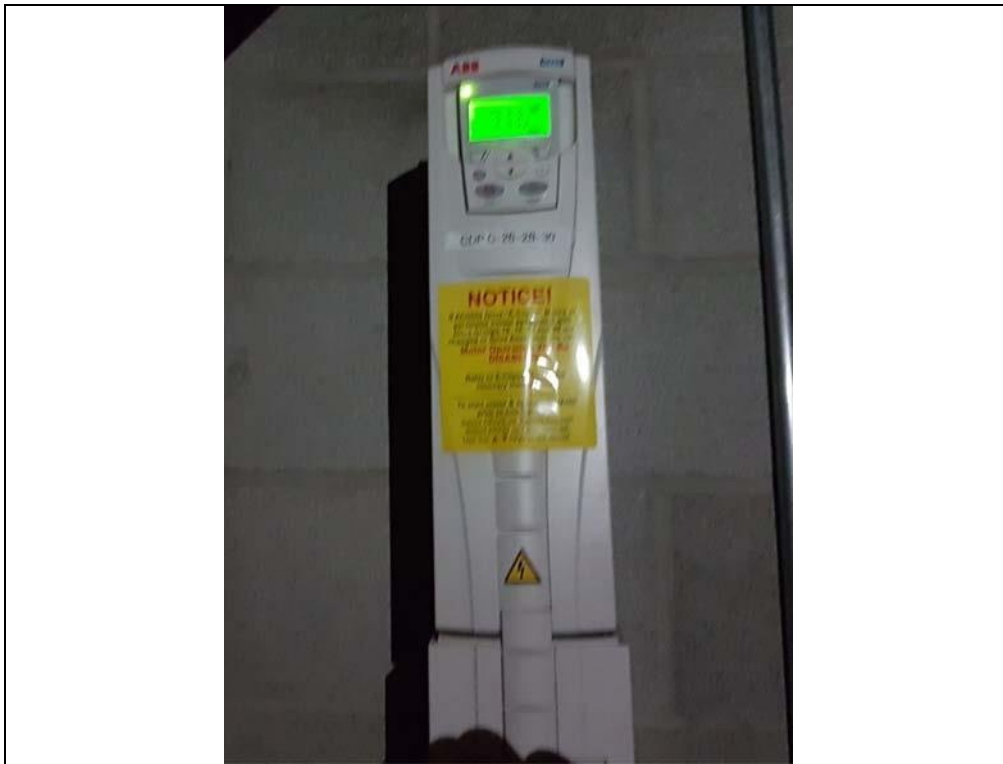
Variateur ACH550 VFD HVAC 600V 15HP 17A NEMA1 avec dérivation, interrupteur de service.
