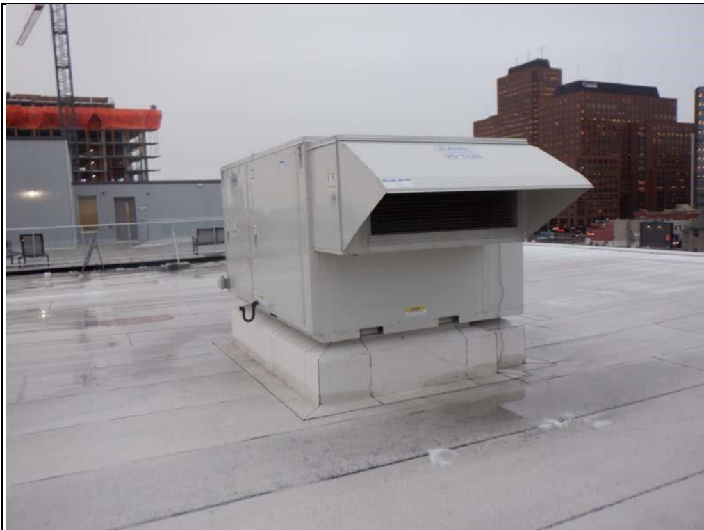
Unité de chauffage et refroidissement au toit, AAON rn-025-4-0-e709-000.
