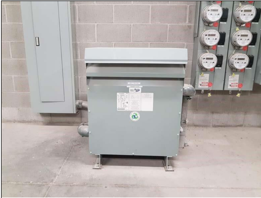
Transformateur Delta 75 kva 600-208Y/120 60Hz, CD6A0075VHA6XXBD.
