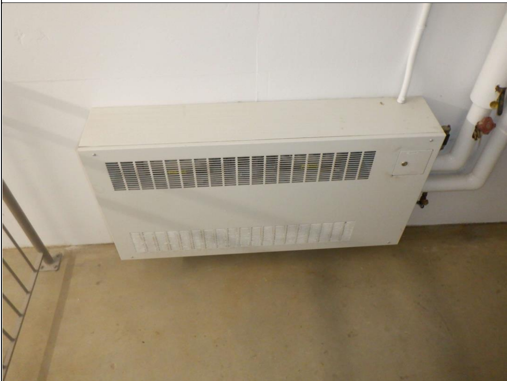
Chaufferette à air propulsée (convecteur) SIGMA CORPORATION CWF 48x26x6.5.
