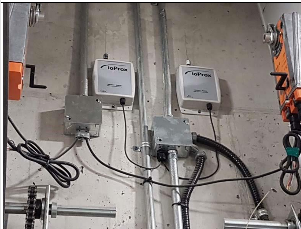
Récepteur et émetteurs sans fil ioProx 4-Channel Receiver XSF/ 26-Bit Wiegand, Kantech P700WLS.
