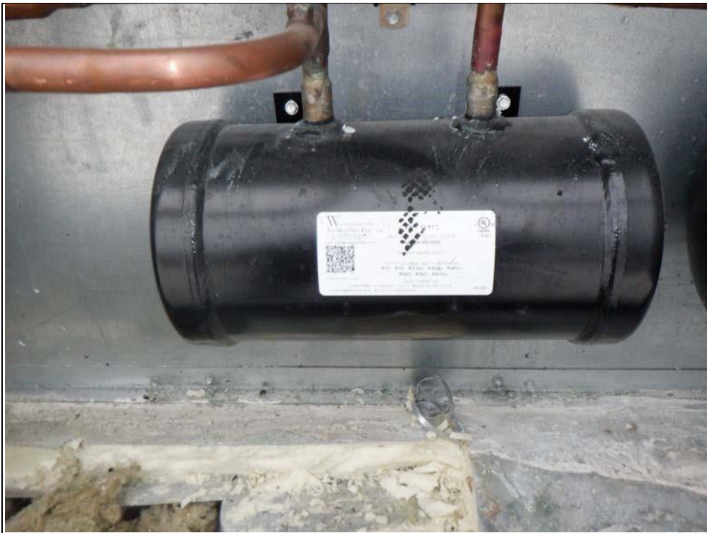
Récepteurs de liquide UL haute pression pour appareil au toit Westermeyer Industries, IncR6-04G.
