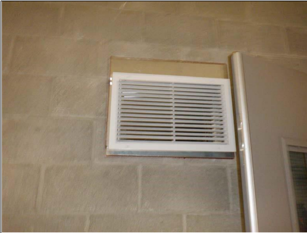
Grille Retour Simple déflexion GSA4 dimension approximative 14''(larg) X 8''(haut).
