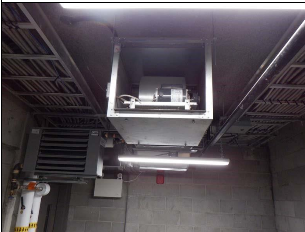
TF-P1.5 Moteur à usage général Marathon 0,75 HP, 1 phase, 1800 tr / min, 115 /208-230 V, 56 châssis, ODP - B319 Marathon B319.
