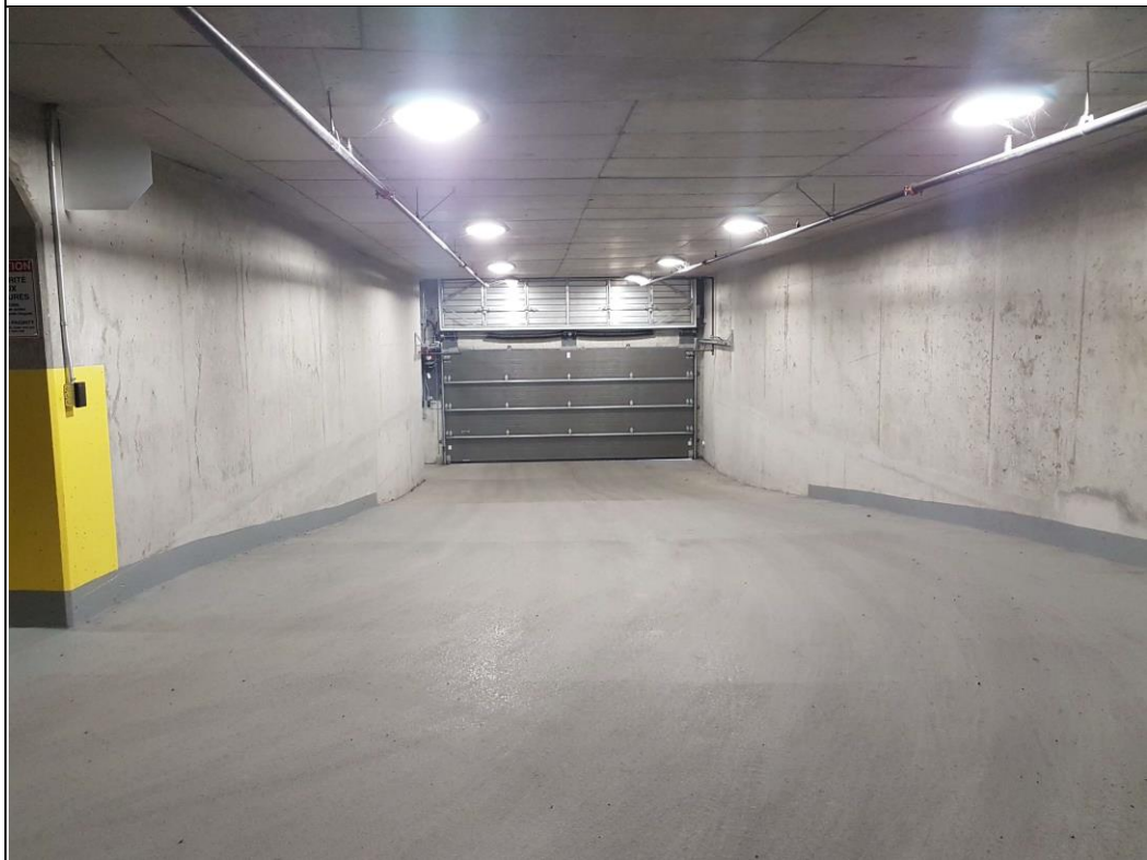
Entrée du garage P-1.
