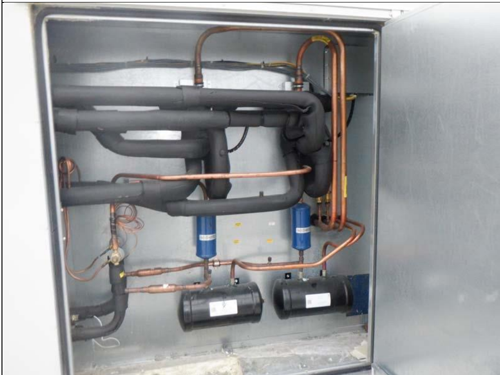
Vue générale de la porte arrière au milieu.
