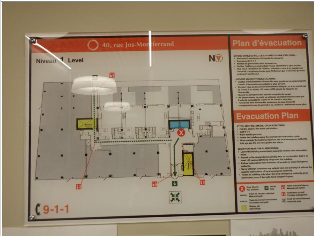
Panneau d'évacuation, Niveau 1.
