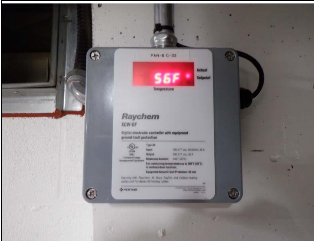
Contrôleur de fils chauffant Raychem ecw-gf controller.
