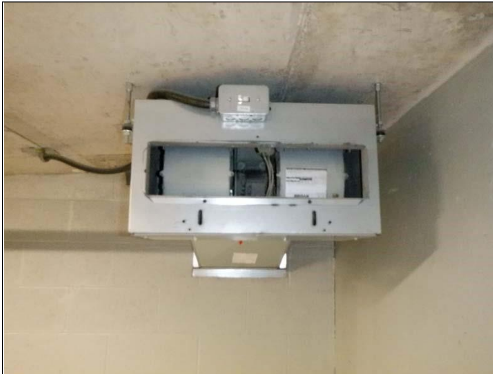
Ventilateur haute capacité Broan-Nutone L700L, ventilateur d'extraction commercial, 3,7 sons, 681 CFM.
