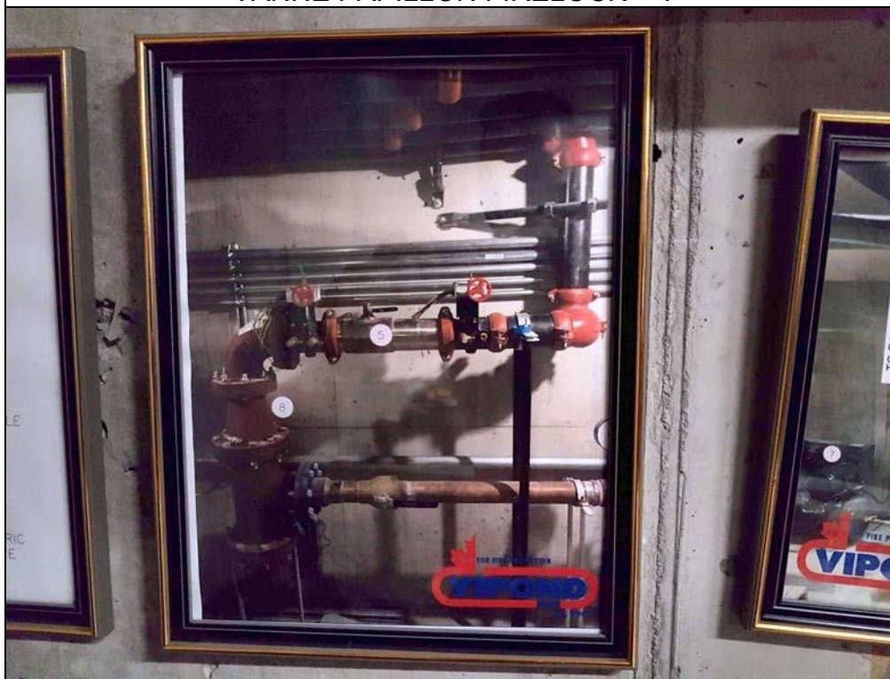
(5) Ensemble de clapet anti-retour à double clapet anti-retour en acier inoxydable de 4 pouces WWATTS Model 757N; (6) Vanne à soupape NPT de 2" (50,8 mm) QRFS NPT.
