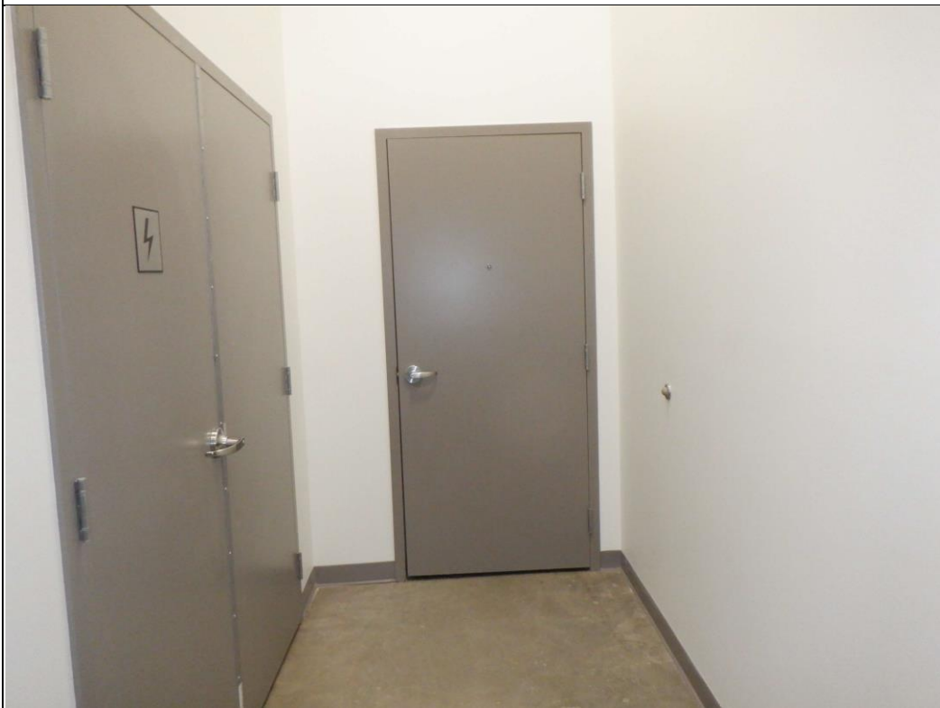
Porte type corridor au rez-de-chaussée.
