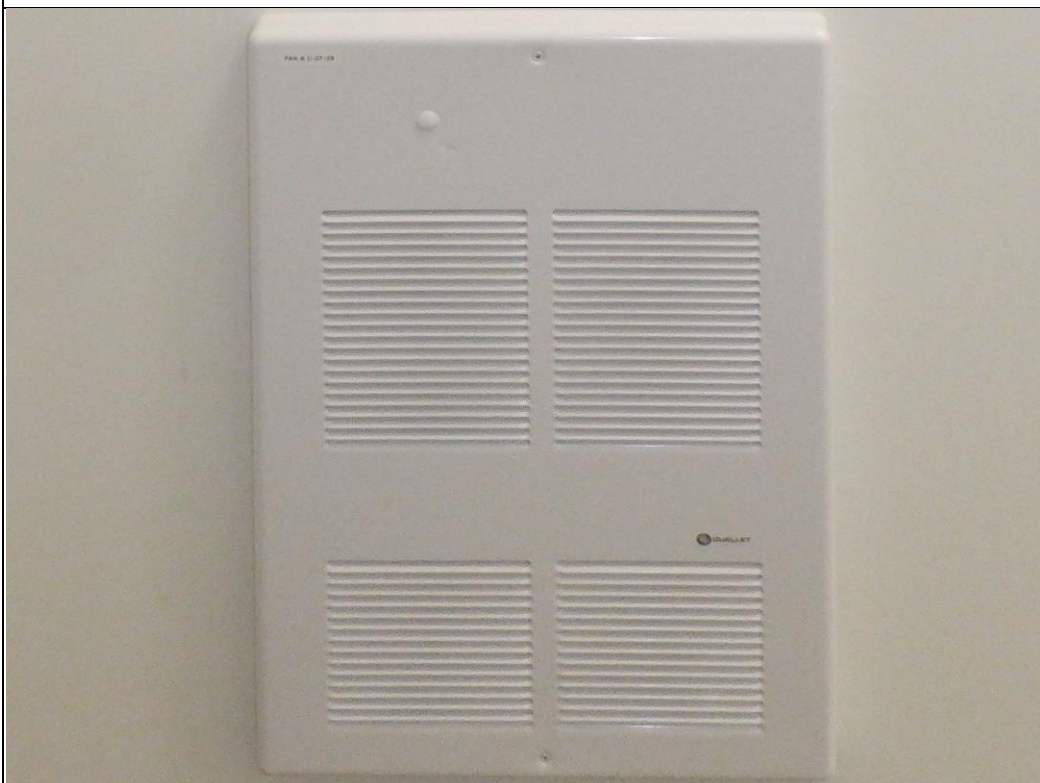
Chauffage 4k aéroconvecteur de Ouellet.
