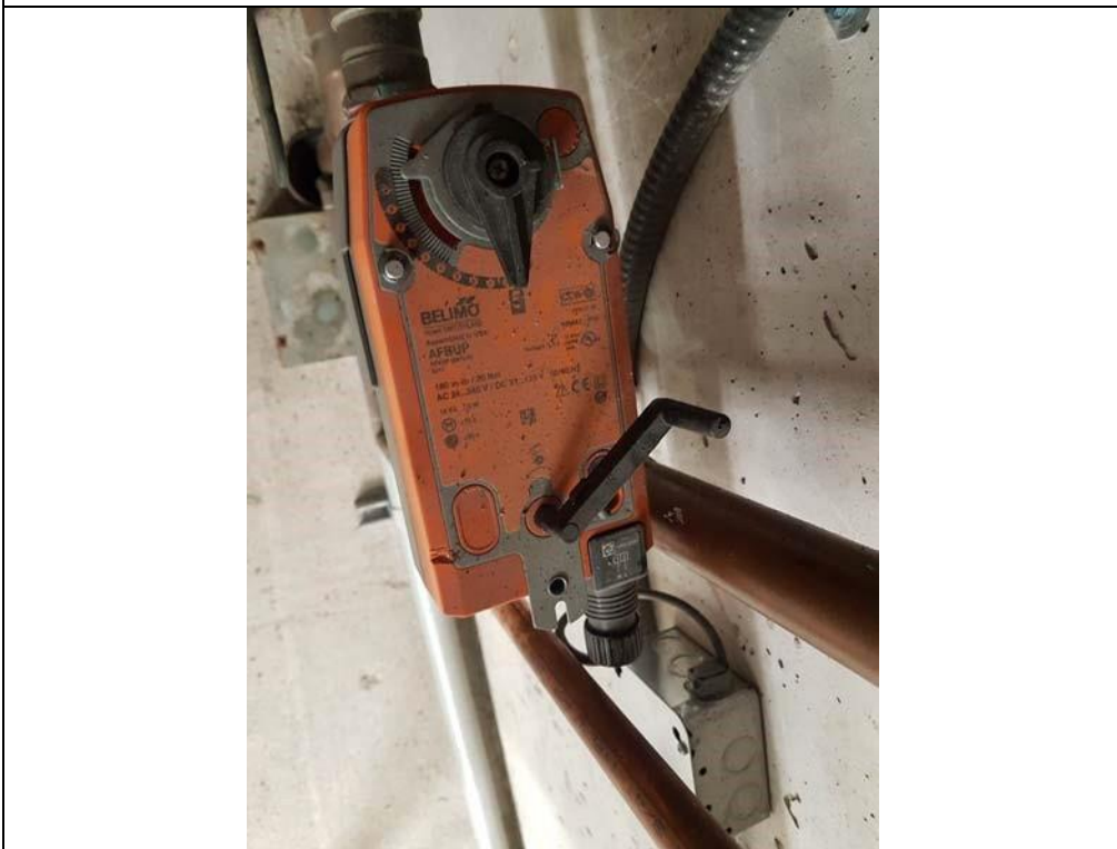
Servomoteur de registre, 180 in-lb [20 Nm], Ressort de rappel, AC 24...240 V / DC 24...125 V, Marche-Arrêt BELIMO AFBUP.
