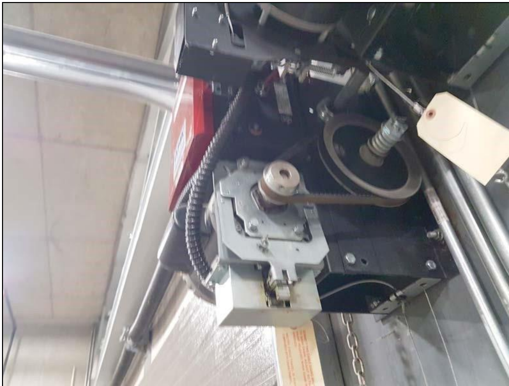
Actionneurs de porte commerciale Logique de LiftMaster 5,0.
