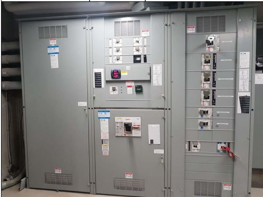
Les 3 Tableaux de distribution général Pow-R-Line C 2000 AMPS 347/600VAC 3PH/4F EATON PRLC
