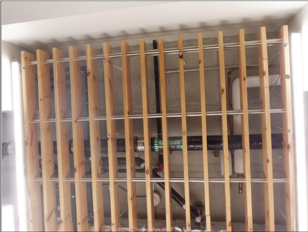
Décoration au plafond de l'entrée Structure de bois fait sur mesure.
