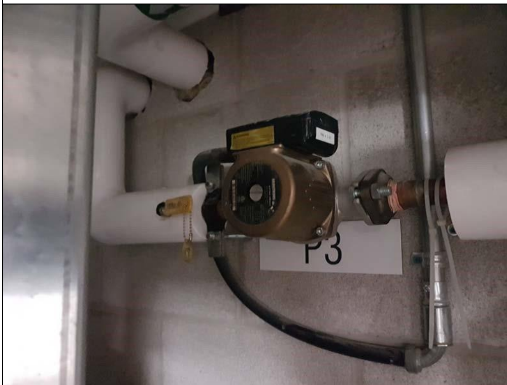
Armstrong 110223-306 1/25 Puissance Astro 230SS circulateur avec circulateur d'Acier inoxydable Armstrong Astro 230SS.
