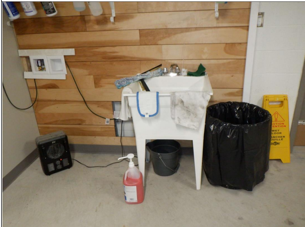
Raccord pour laveuse et cuve à lavage.
