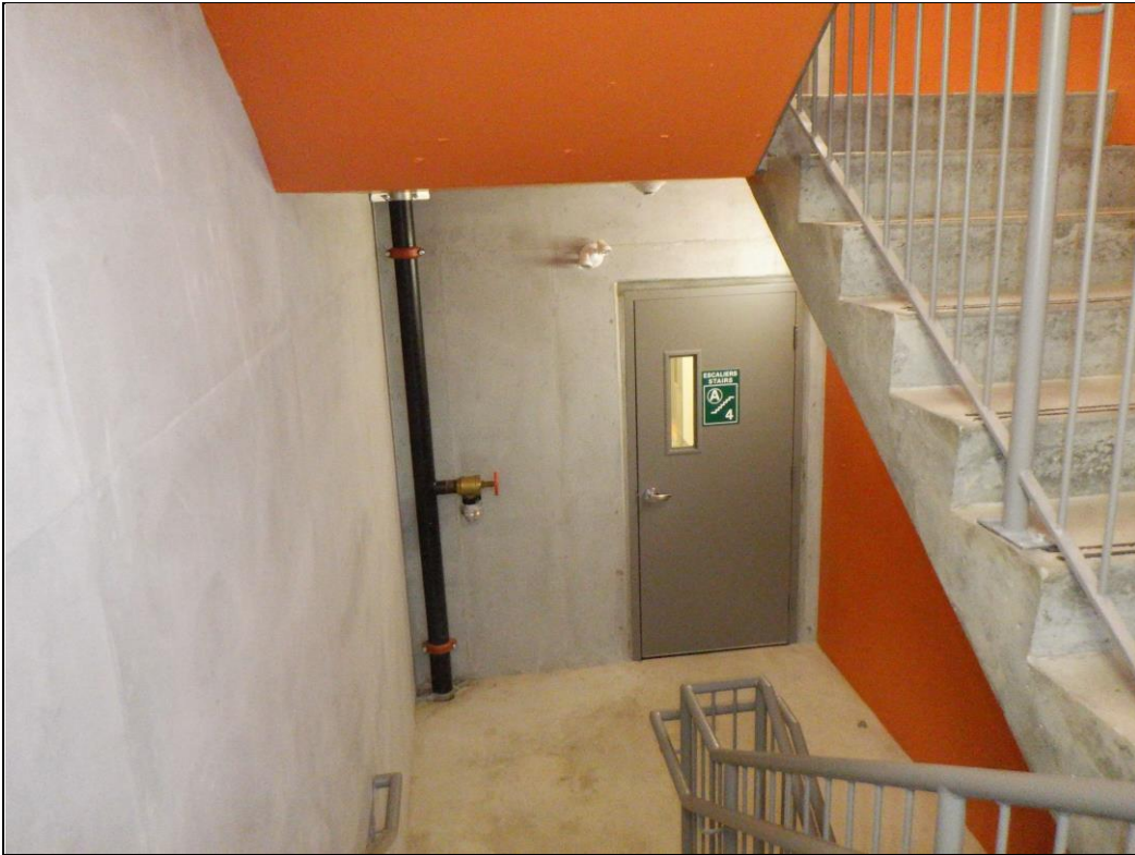
Porte donnant accès à l'escalier niveau 4.
