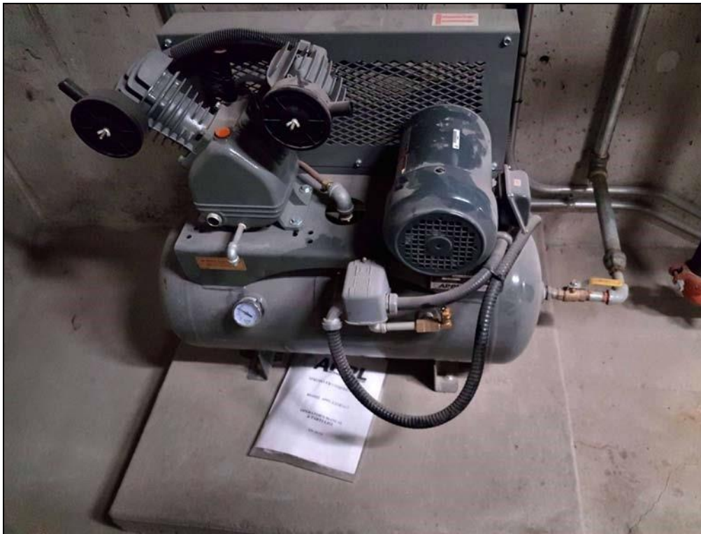
Compresseurs d'air sprinkler à sec APPL-LX5R14 APPL LXR14.
