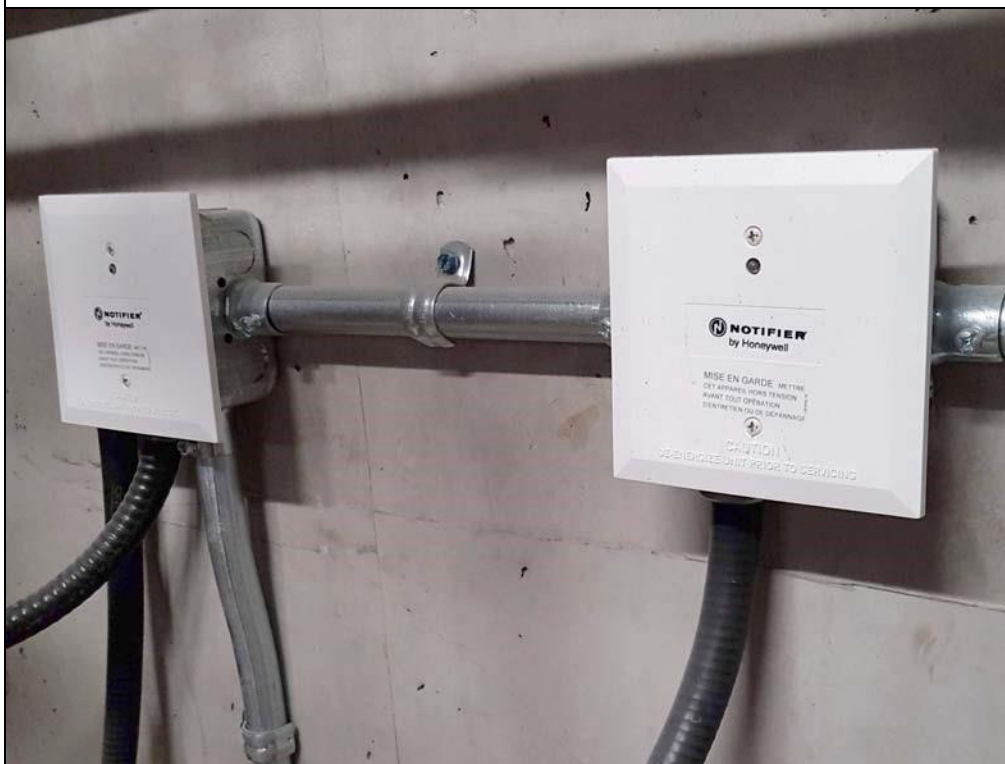
Indicateur d'alarme d'Honeywell.
