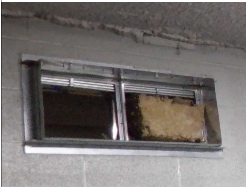
Clapet coupe-feu type rideau 24x12 UL 555 1,5 heures avec manchon intégral de 12" RUSKIN CANADA IBD20.
