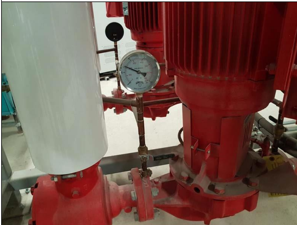
Manomètre à boîtier rempli de liquide en acier inoxydable de 4 po avec raccord inférieur de 1/4 po NPT et plage de 0 à 100 psi / kPa WINTERS INSTRUMENTS.
