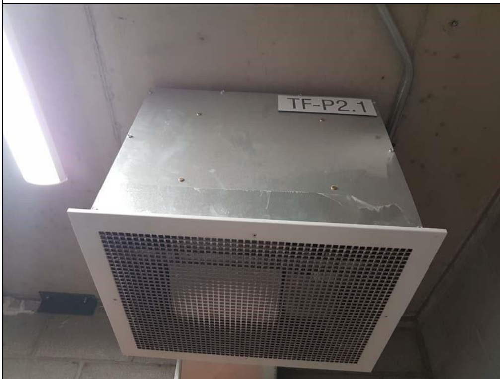
Ventilateur haute capacité Broan-Nutone L1500, ventilateur d'extraction commercial, 8,4 sons, 120 V, 1513 CFM.
