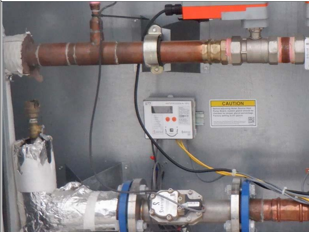
Compteur de chaleur Électronique - calculateur à microprocesseur, Sontex, Supercal 531.
