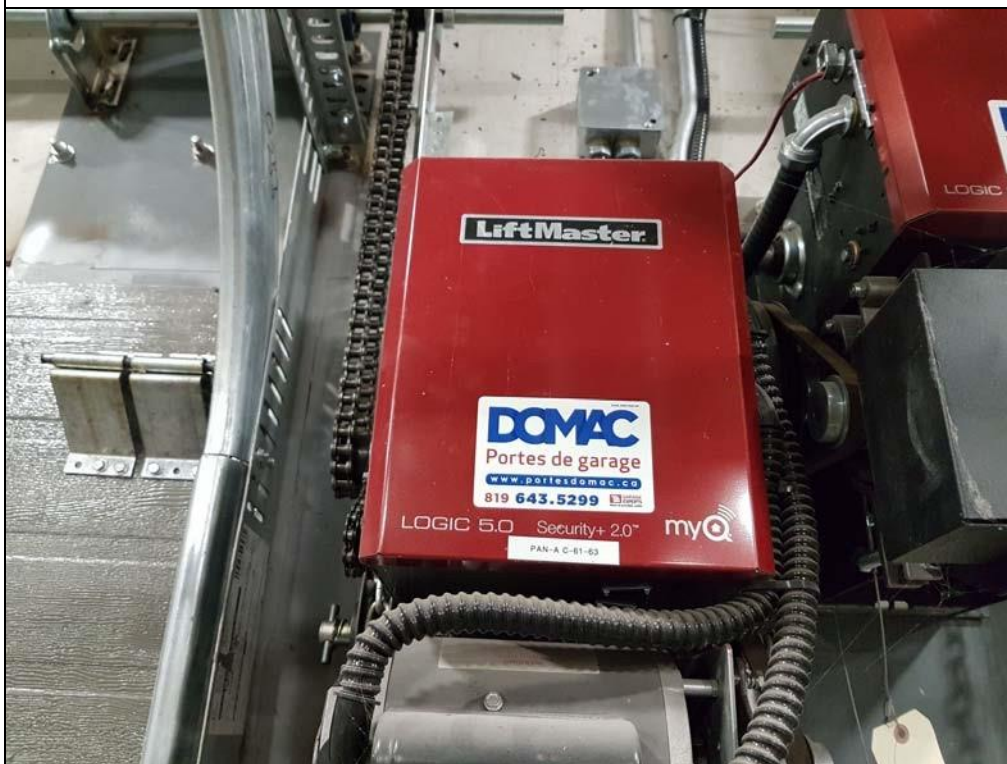
Actionneurs de porte commerciale Logique de LiftMaster 5,0.
