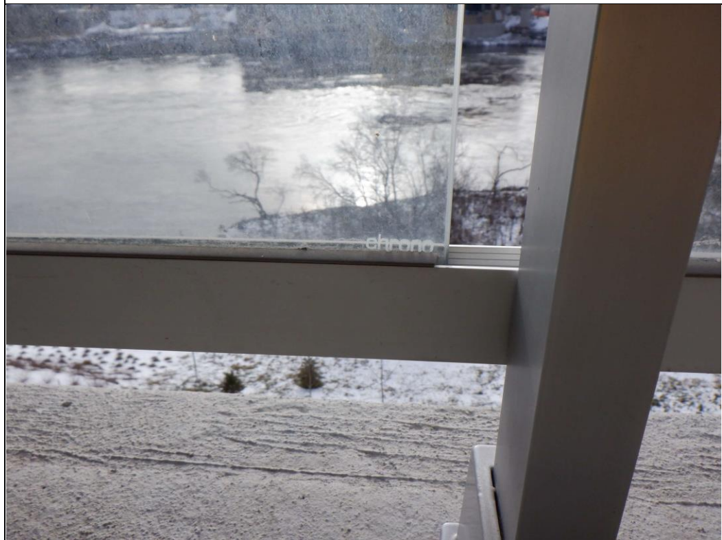
Vitrage des garde-corps des balcons Chrono.
