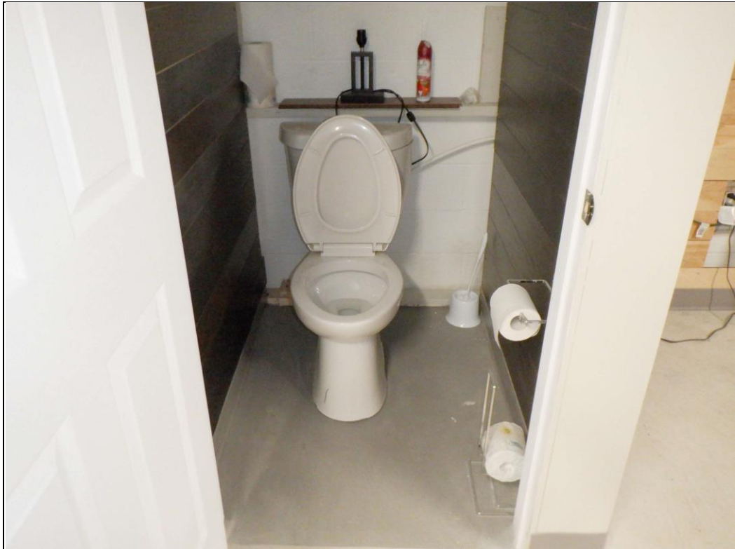
Toilette ajoutée dans la salle de maintenance niveau -P1.
