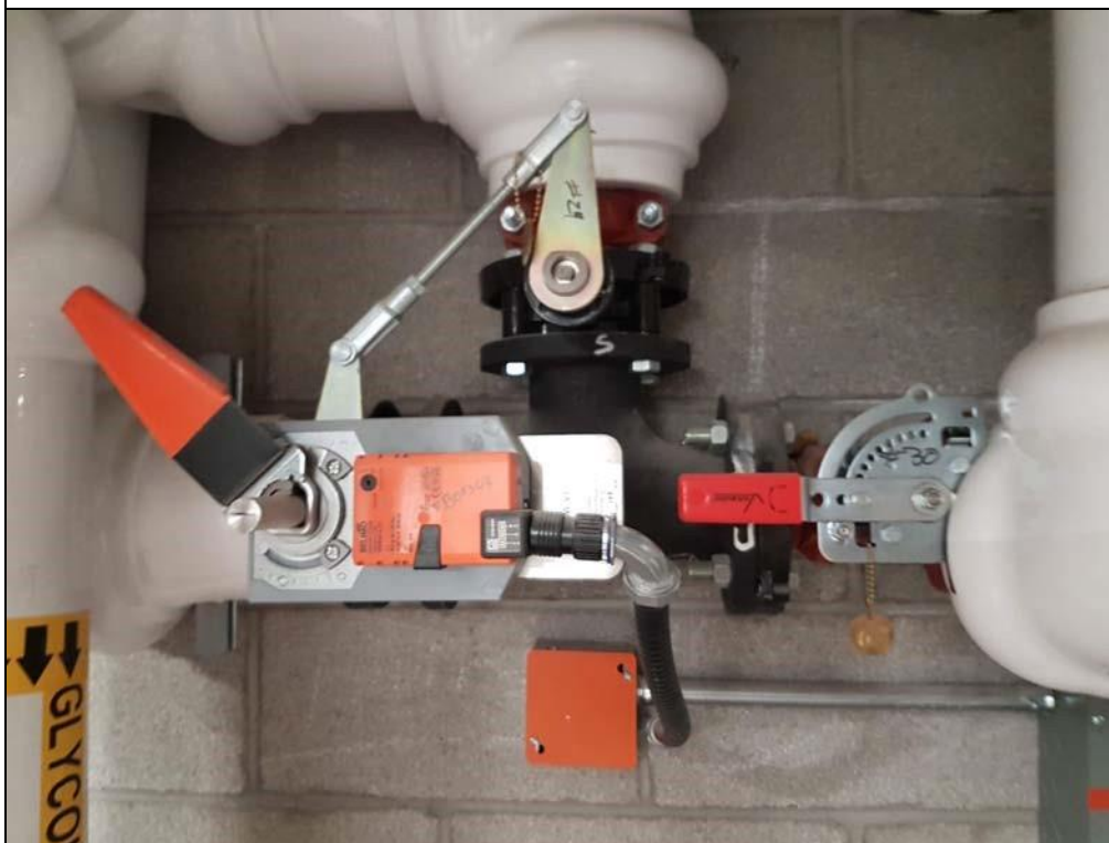
Vanne papillon (BFV), 3 ", 3 voies, classe ANSI compatible avec 125, actionneur de vanne Cv 302, sans sécurité, AC / DC 24 V, marche / arrêt, actionneur à virgule.
