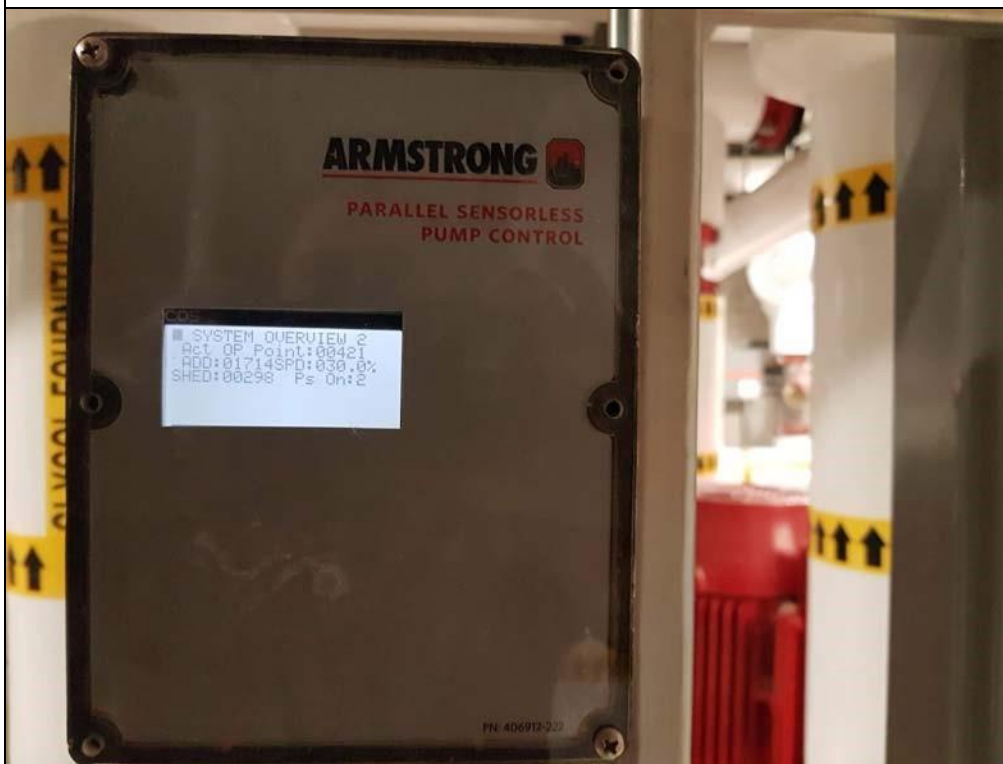
Contrôleur de pompe électronique (Parallel sensorless pump controller) Armstrong fluid technology.
