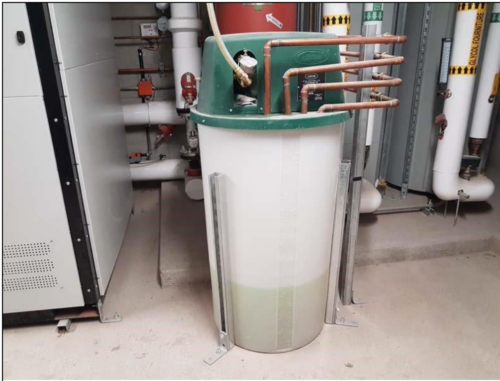
Réservoir d'accumulateur (System Feeder Pressure Pal, 55USG, 25-85psi) AXIOM SF100.
