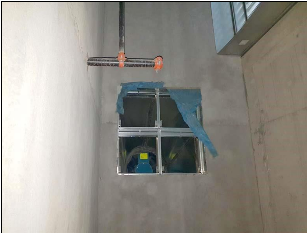
Clapet coupe-feu type rideau 24x24 UL 555 1,5 heures avec manchon intégral de 12".
