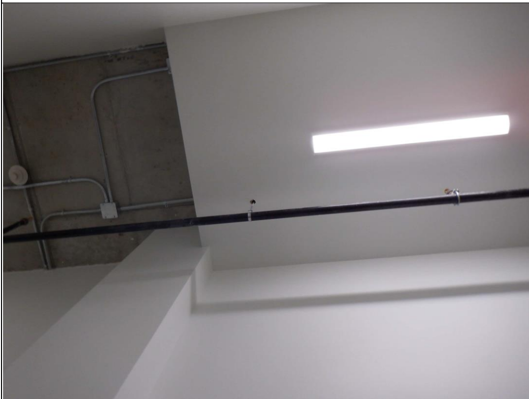
Plafond type au R-de-C.
