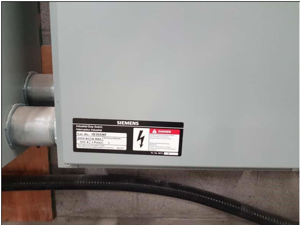
SIEMENS CANADA ID366NF 600Amp 600VAC 250VDC 3 pôles Siemens interrupteur à usage industriel sans fusible boîtier EEMAC 1.
